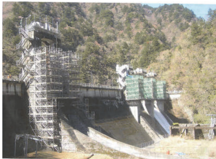
写真-2 施工状況
