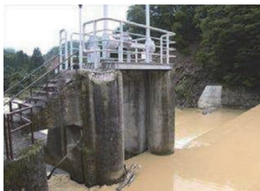
写真-2 取水堰堤排砂門ピアの損壊状況
