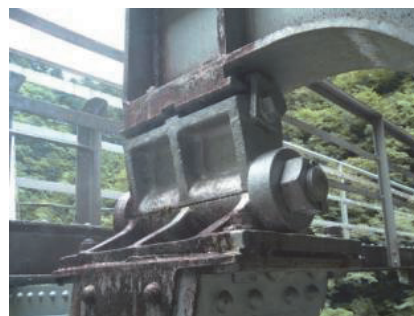
写真-2 鋼製ロッカ支承
