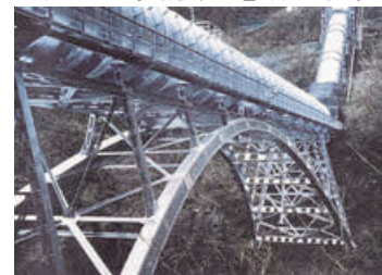
写真-1 奥泉発電所 関の沢水管橋
