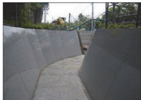
写真-4 FRPM板ライニング工法施工後
