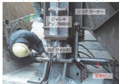
写真-2 支承ピン取替状況
