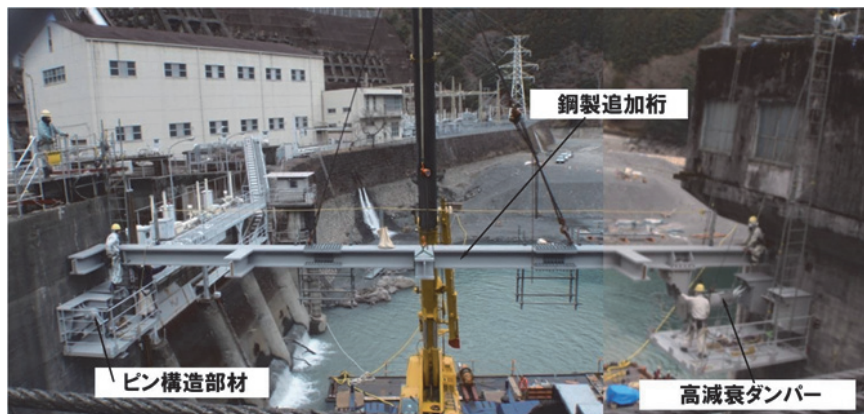
写真-6 追加桁架設状況
