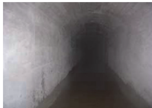
写真-10 打替え箇所施工完了状況
