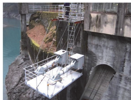
写真-5 高減衰ダンパー仮吊状況
