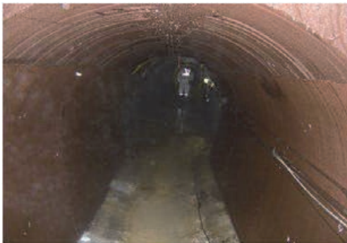
写真-3 支保工内巻鉄板施工後
