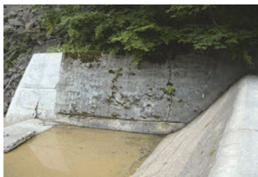
写真-2 取水堰堤排砂門ピアの損壊状況
