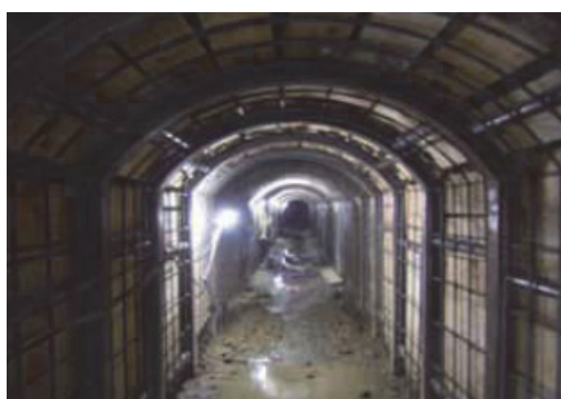
写真-9 支保工・鉄筋組立状況
