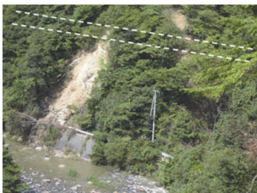
写真-1 導水路付近の地山の被災状況
