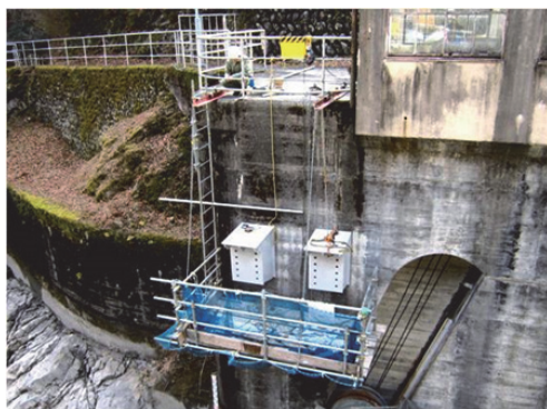
写真-3 支承部材設置状況 (高減衰ダンパー側)
