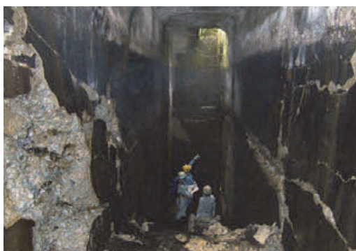
写真-1 導水路付近の地山の被災状況
