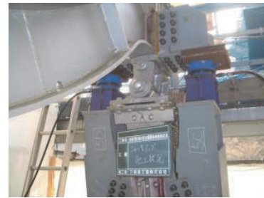
写真-4 ジャッキアップ状況
