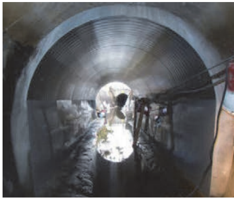
写真-6 FRPM 板ライニング工(トンネル部)
