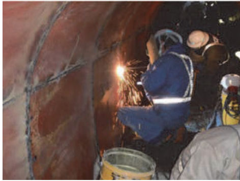
写真-5 鋼板取付 溶接状況
