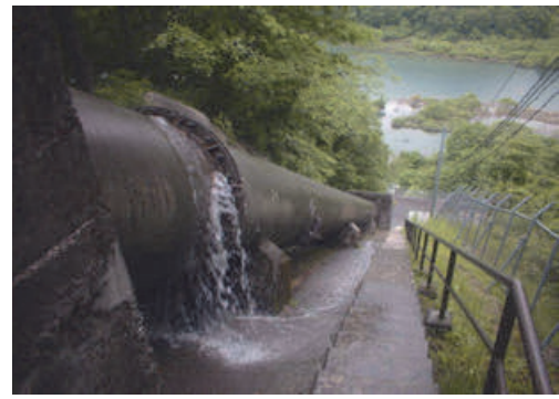
写真-2 水圧鉄管(伸縮継手部)からの漏水状況
