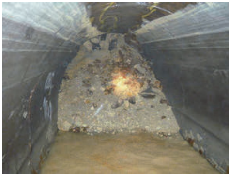
写真-1 導水路トンネルの損壊状況
