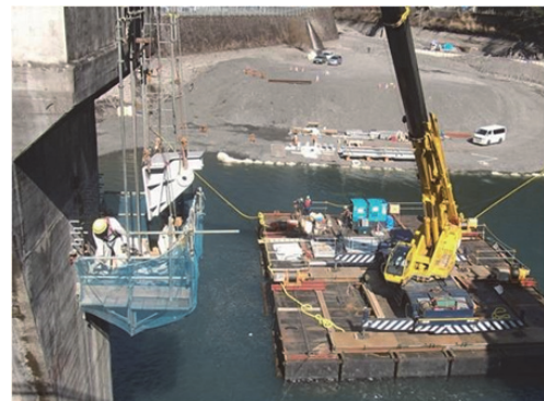
写真-4 支承部材設置状況(ピン側)
