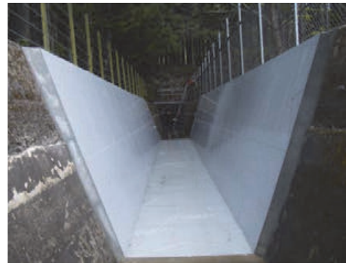
写真-7 FRPM 板ライニング工(開渠部)
