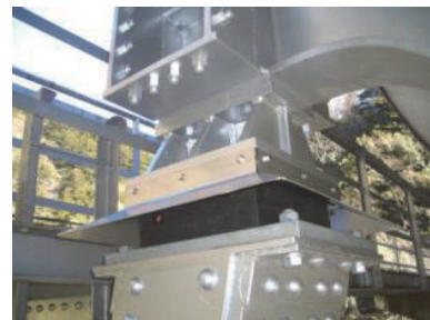
写真-5 免震ゴム支承の設置状況
