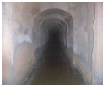
写真-8 施工状況(PFモルタル吹付)
