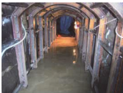
写真-5 支保組立状況
