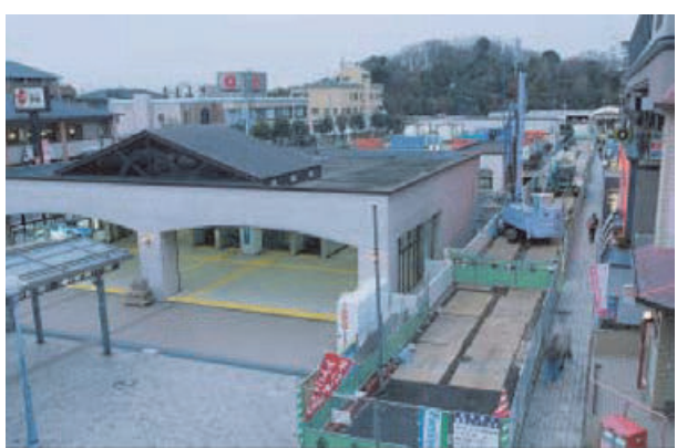
図-2.1.12 開削トンネルの免震工法（横浜市営地下鉄中川駅の耐震補強事例） 3), 4)
