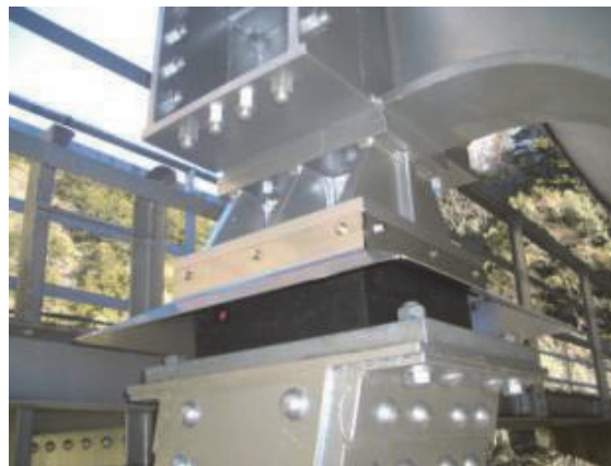
写真-2.1.3 免震ゴム支承の設置事例（事例シート1-3）
