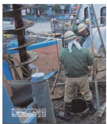
図-2.1.12 開削トンネルの免震工法（横浜市営地下鉄中川駅の耐震補強事例） 3), 4)
