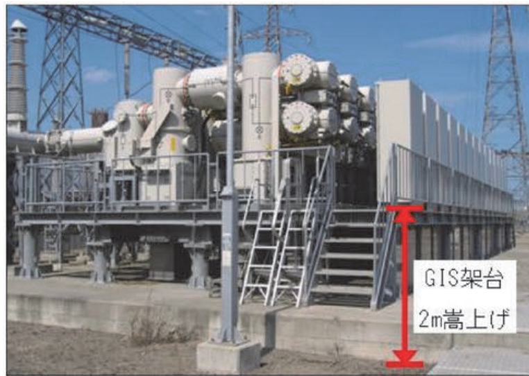
図-1.2.7 架台嵩上げによる津波対策事例（八戸変電所GIS架台） 57)
