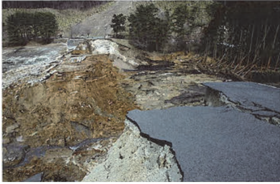
写真-1.1.13 藤沼ダム(アースフィルダム)の決壊(福島県) 47)
