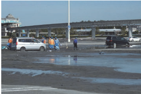
写真-1.1.8 東京ディズニーリゾート(浦安市)の液状化被害 42) 写真-1.1.9 在来工法による体育館天井の脱落被害 43)
