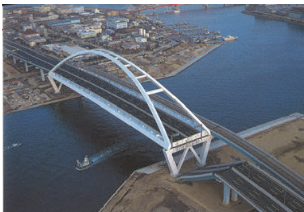
写真-1.1.4 西宮港大橋側径間の落橋 14),15) (阪神高速道路5号湾岸線)
