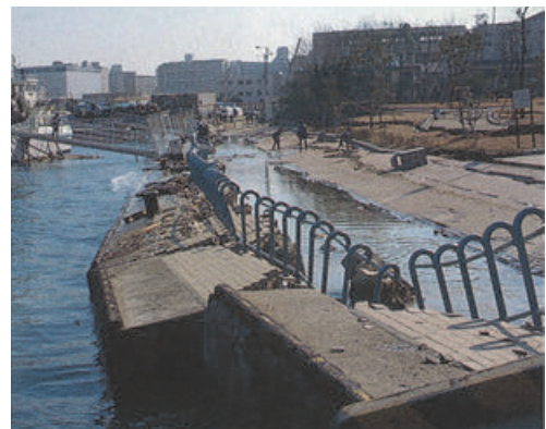
写真-1.1.3 ポートアイランド北公園護岸の崩壊 14),15)
