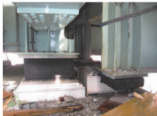
写真-1.1.11 仙台東部高架橋ゴム支承の破断 46)
