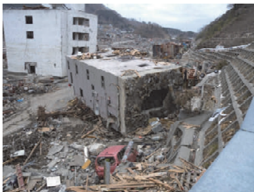
写真-1.1.10 杭基礎RC建物の倒壊(女川町) 45)
