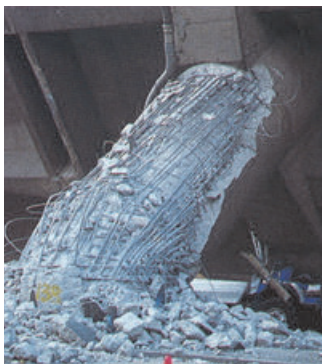
写真-1.1.1 東灘高架橋橋脚の倒壊 14),15) (阪神高速道路3号神戸線)
