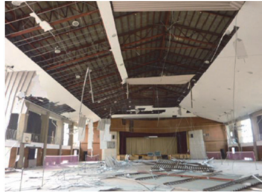
写真-1.1.8 東京ディズニーリゾート(浦安市)の液状化被害 42) 写真-1.1.9 在来工法による体育館天井の脱落被害 43)
