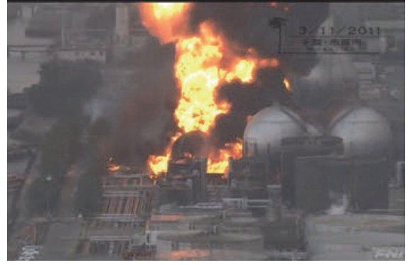
写真-1.1.14 コスモ石油千葉製油所LPGタンクの火災・炎上 48)
