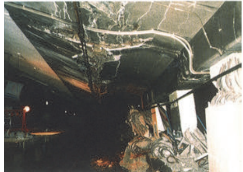
写真-1.1.2 地下鉄大開駅中柱の圧壊 14),15)
