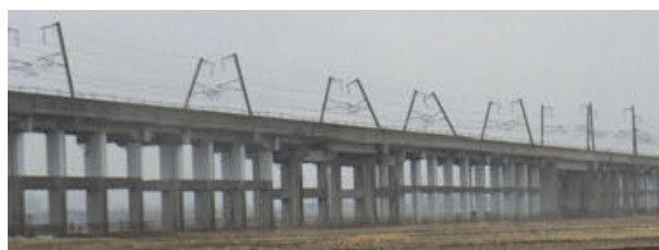
写真-1.1.12 東北新幹線電化柱の被害 42)
