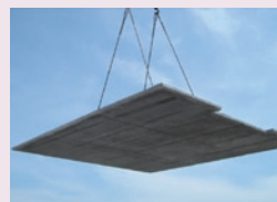
棧橋床版用埋設型枠
