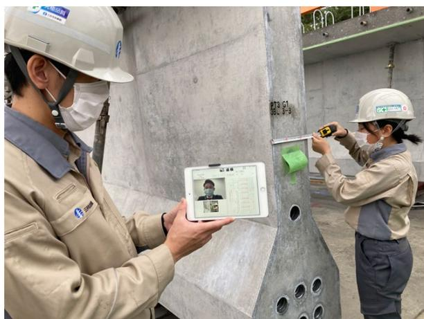
写真1 遠隔検査システム「遠検」実施状況
