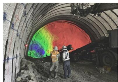
写真3 地盤硬軟コンター図
