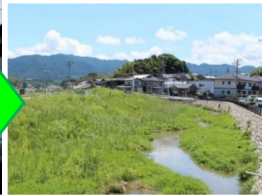
川幅を広げ安全性の向上と環境に配慮した河川改修 14) (多自然川づくり)
