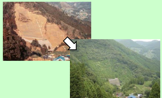
写真-2 山腹工(静岡県島田市) a4.1)
