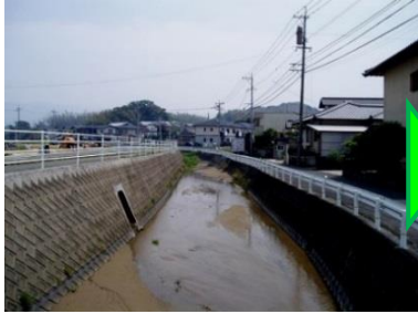
川幅を広げ安全性の向上と環境に配慮した河川改修 14) (多自然川づくり)
