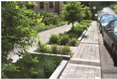
道路沿いの緑地で雨水排水を一時的に貯留し、流出を遅らせたり浸透させ、洪水を防止 10) (バイオスウェイル)
