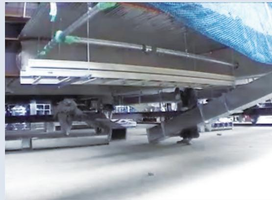
設備機器、ダクトを架台鉄骨や梁鉄骨に先付したユニットを現場や工場で作成し、揚重・取付を行うことで、現場作業の削減、足場等仮設の削減が図れます。
