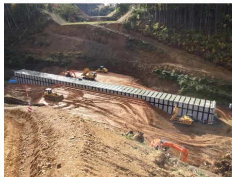
ICT 建機を用いた敷均・転圧状況
