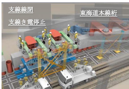
① 支線き電停止・当該線線閉完了後、作業開始
