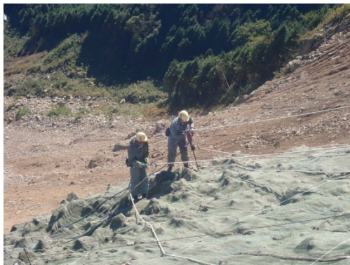
写真.2 アンカー削孔状況
