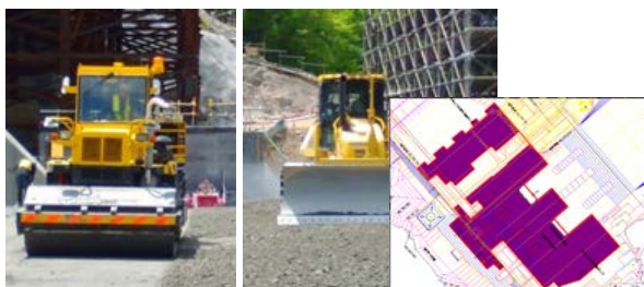
図-2 GNSS 搭載振動ローラ・ブルドーザ
