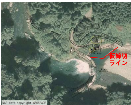
図-5 施工現場の周辺環境
