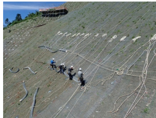
写真.3 ネット設置状況
