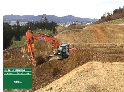
MGバックホウ施工状況
