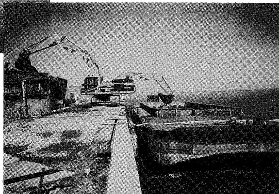
写真 3-2-1 浚渫土砂揚土施工状況
