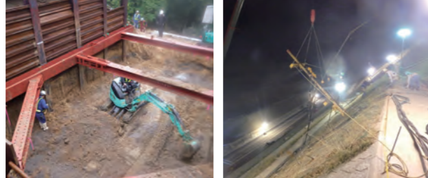
宮崎自動車道での復旧工事
