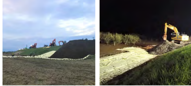
千曲川での復旧工事
