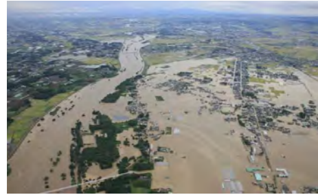
茨城県常総市での鬼怒川堤防決壊の様子 (写真提供:国土交通省関東地方整備局)
