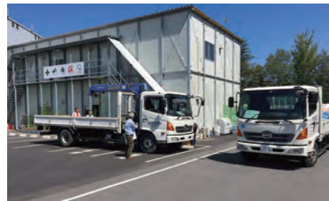
復旧作業における建設資材調達および運搬作業の様子
