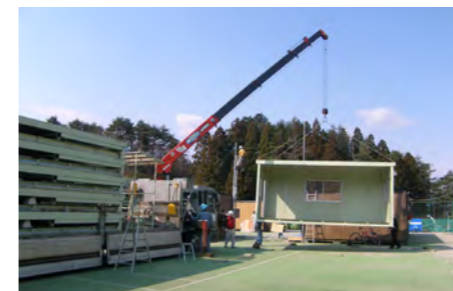
仮設ハウスの設置
