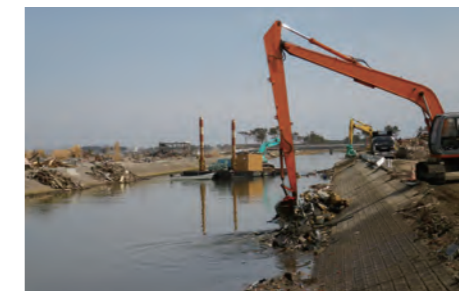
宮城県仙台市の貞山運河でのがれき処理
