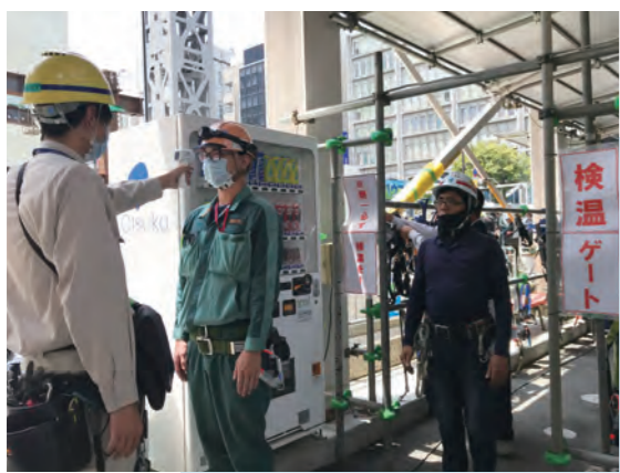
新型コロナウイルス対策を実施する建設現場の様子
