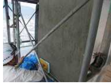
写真-5.21 こて仕上げ
