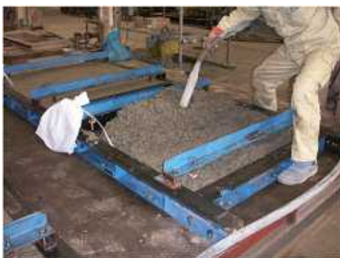
コンクリート打設状況 1
