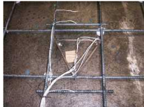
熱電対設置状況 1
