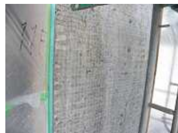
写真-5.6 吸水調整材塗布後
