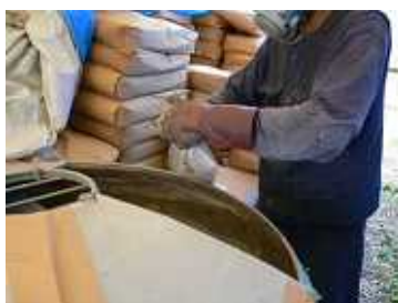
写真-5.10 混和液の投入
