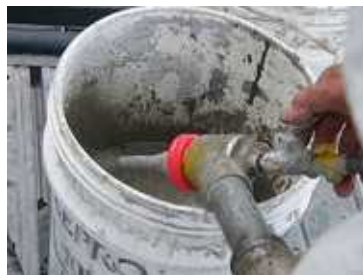
写真-5.14 モルタル量・エア量調整
