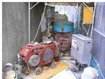
写真-5.7 機材の設置
