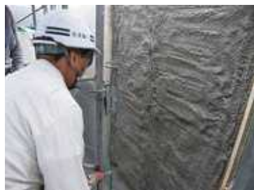
写真-5.18 吹付け施工
