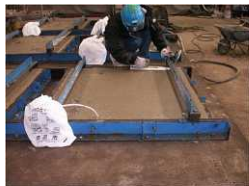
コンクリート打設状況 2
