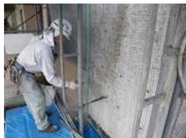
写真-5.5 吸水調整材塗布
