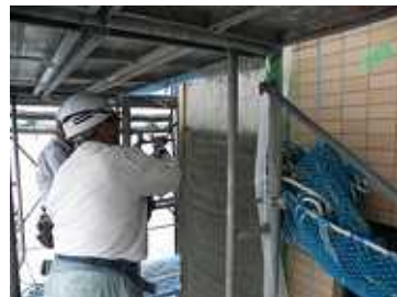
写真-5.17 吹付け施工
