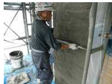
写真-5.19 定木ずり
