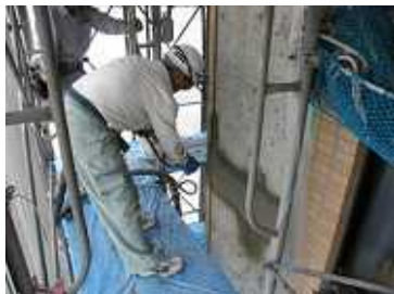
写真-5.16 吹付け施工
