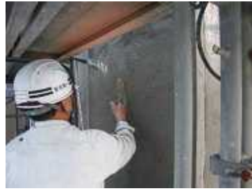
写真-5.20 こて仕上げ
