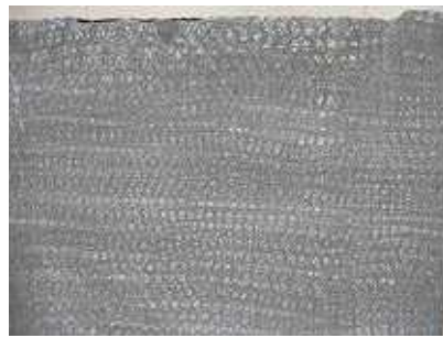
写真-5.2 超高压洗浄(例)
