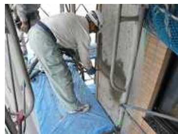
写真-5.15 吹付け施工
