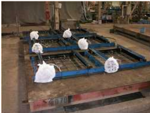
コンクリート打設前型枠状況
