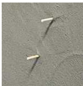
写真-6.1 アンカー孔養生
