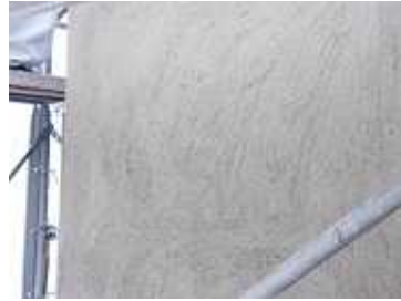
写真-5.22 仕上がり
