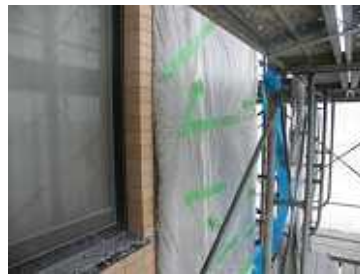
写真-5.24 養生(一例)
