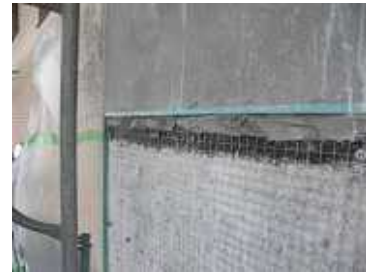
写真-5.23 目地部での塗り継ぎ
