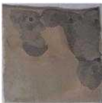
状態 : 部分的な内部の爆裂
