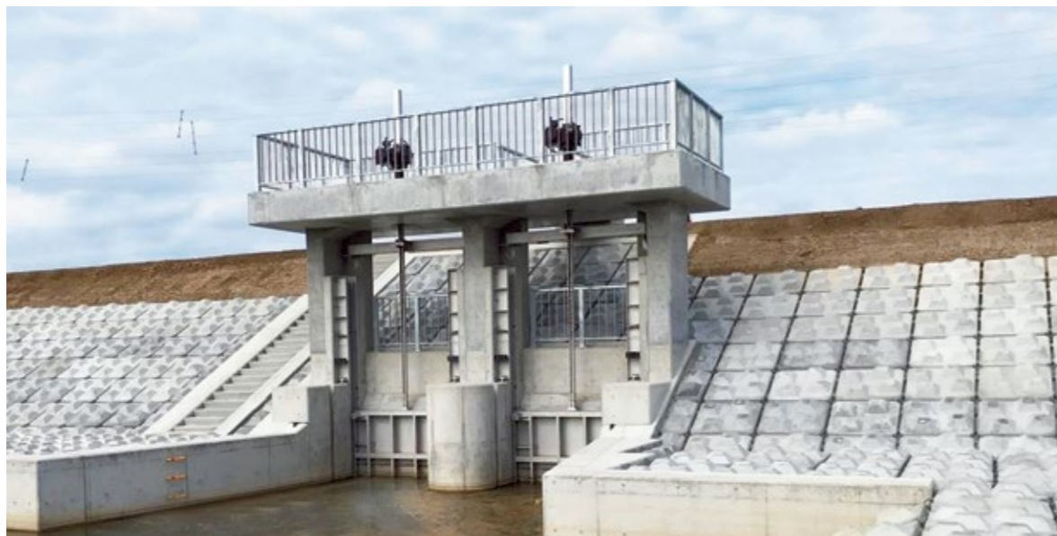
写真・1 樋門（機場排水口）完成全景
