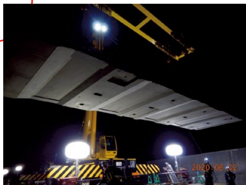
床版取替状況写真
