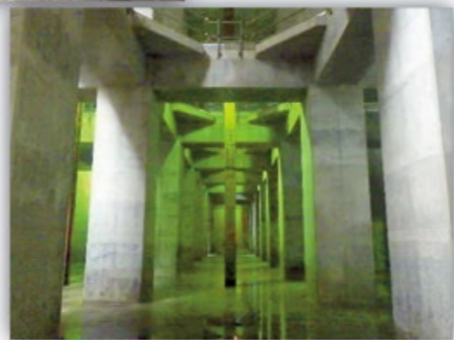
第2ポンプ場 鉄筋コンクリート施工後 (貯留施設)
