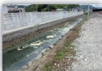
第1ポンプ場 施工前
