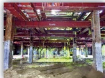
第2ポンプ場 20m 掘削
