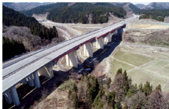
新遠部沢橋下り線 (2020年度施工予定)
