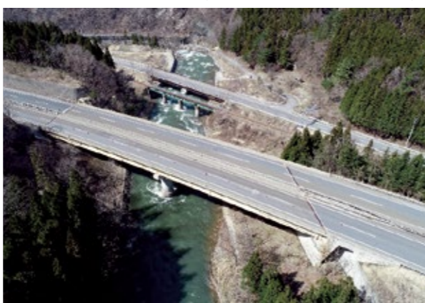
西石通橋下り線 (2021年度施工予定)
