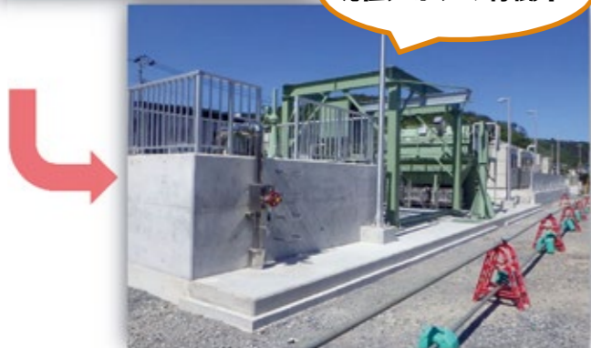
第1ポンプ場 完成
