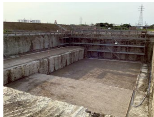
写真・3 機場本体部 掘削状況
