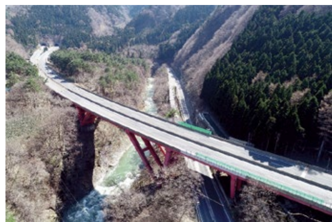
天狗橋上り線 (2021年度施工予定)
