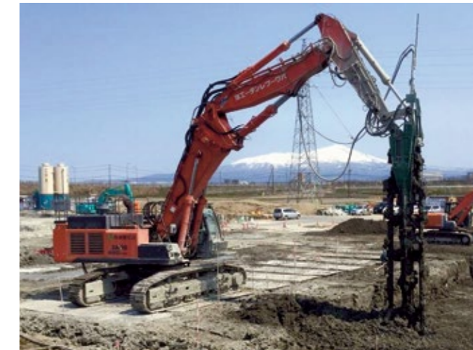
写真・4 パワーブレンダーによる地盤改良
