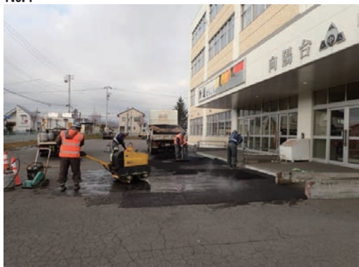
地元中学校舗装補修活動
