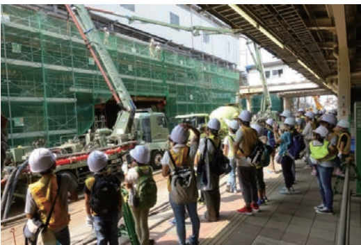
コンクリート打設状況を見学中
