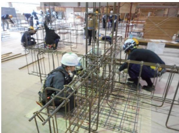
鉄筋組立実習
