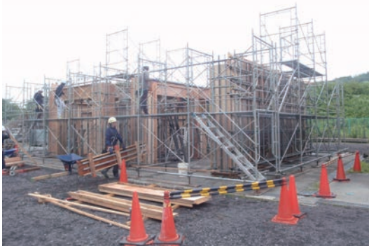
型枠組立実習
