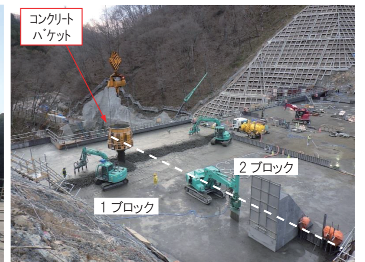
拡張レヤ工法による堤体打設
