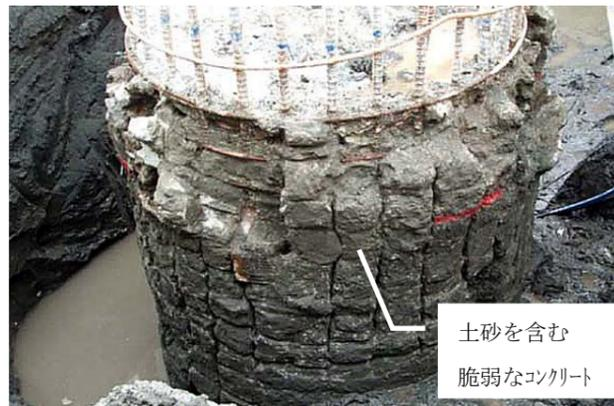
推定要因： コンクリート打設中の孔壁崩壊 他
