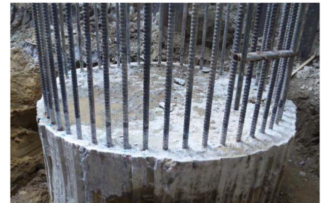
推定要因： 地中障害物の残存、スペーサ設置数・配置が不適切、鉄筋かごの傾斜・偏り、掘削バケットの引き上げ速度が速い 他
