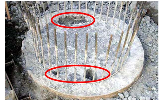
推定要因： 孔壁崩壊、余盛不足、崩壊土砂巻き込み
