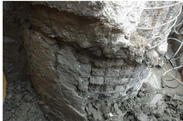
推定要因： スライムが厚い、安定液の比重・粘性・砂分率が高い、余盛不足、スランプロス、トレミー管の挿入長さが長い 他
