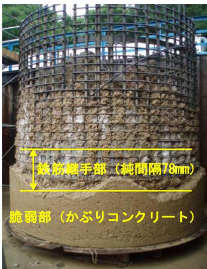
写真 5.1-6 充填不良の事例<sup>6)</sup>
