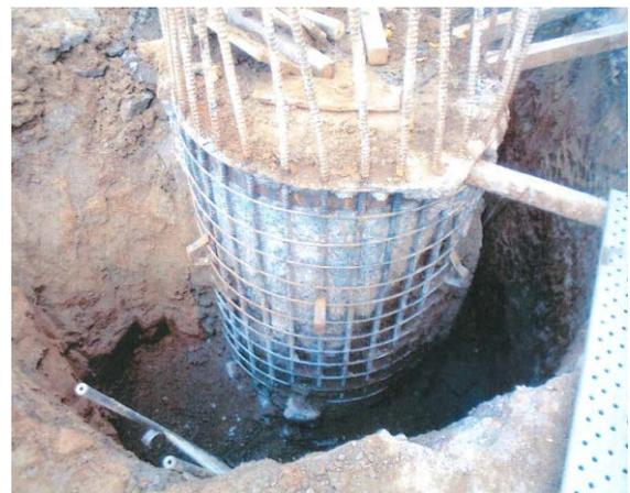
写真 5.1-4 微細砂スライムによる杭頭不良
