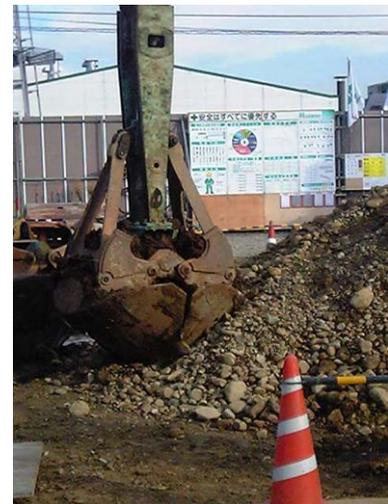
写真 5.1-3 油圧ハンマグラブによる玉石除去例
