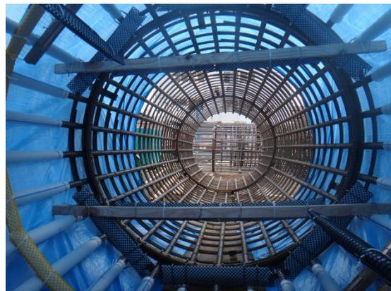
写真5.1-10 鉄筋かごの杭頭部の納まり
