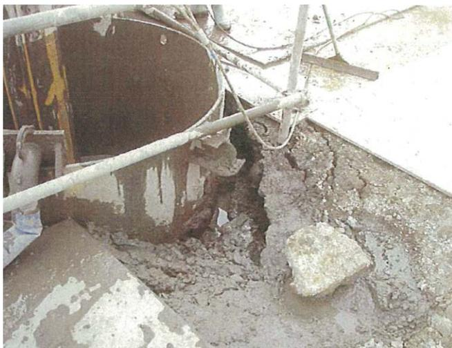
写真 5.2-1 表層ケーシング周囲の表層の崩壊
