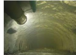
伸縮風管による吸引捕集換気
