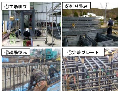
鉄筋ジャバラユニット工法
