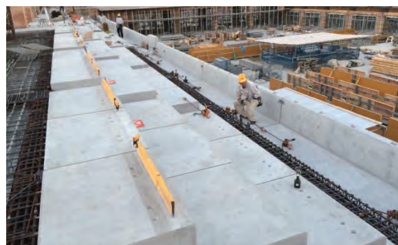
(PCa段床設置完了状況)
