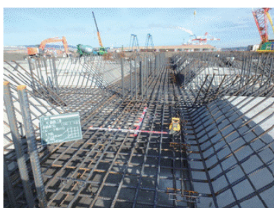
写6-7 基礎下部配筋
