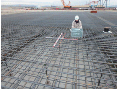
写6-8 基礎版配筋
