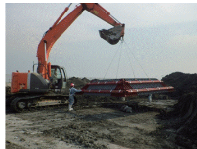
写6-3 型枠の移動状況
