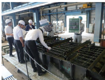
写真11 PCa工場にて鋼製型枠・配筋検査
