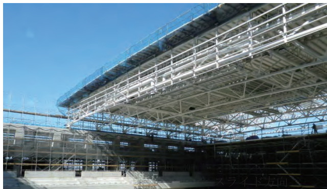
写真9 作業ステージからスライドされた屋根鉄骨
