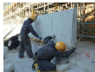
(PCa腰壁設置状況)
