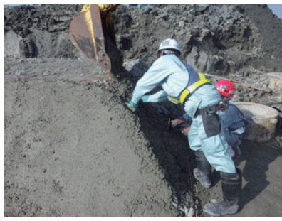
写6-5 法面への捨コン
