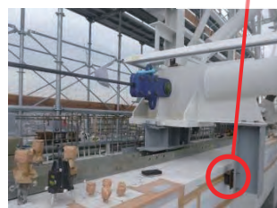
(屋根鉄骨先端)
