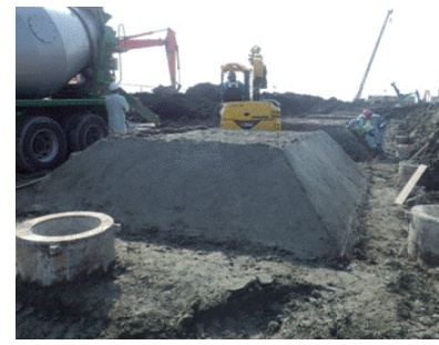
写6-6 捨コン完了
