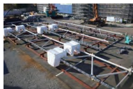
(地組み・溶接状況)
