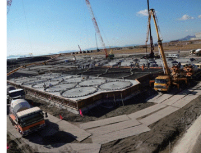
写6-9 基礎コンクリート打
