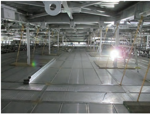
写真-8 クイックデッキ上部
