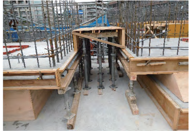
写真-7 免震上部基礎PCa支保工状況
