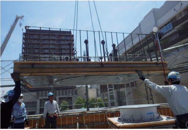
写真-6 免震上部基礎PCa取付状況
