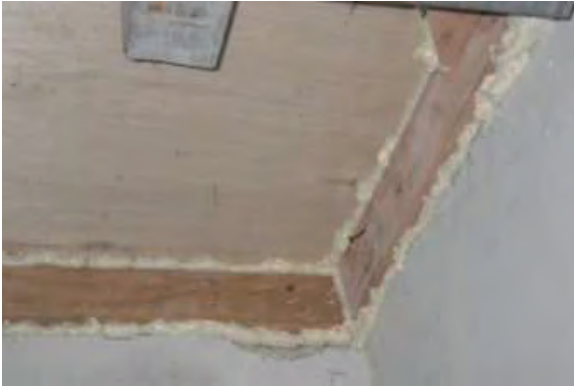
写真－7 型枠の隙間処理状況
