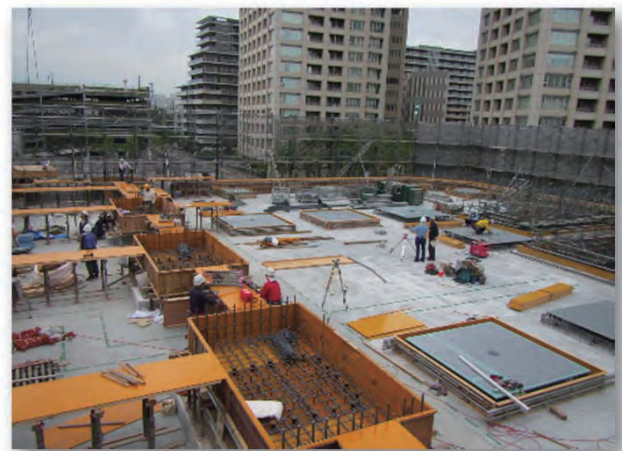
写真-3 在来工法での施工状況
