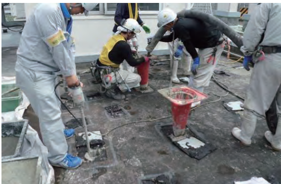
屋上からの床スラブ下面への流し込み状況
