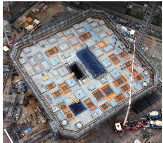
写真-1 サイトヤード状況
