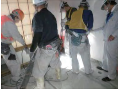
室内床スラブへの流し込みのためのコア削孔状況
