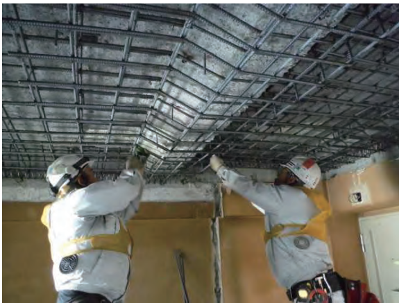
写真-1 配筋施工状況
