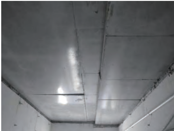
写真一六 スラブ下面のコンクリート出来形
