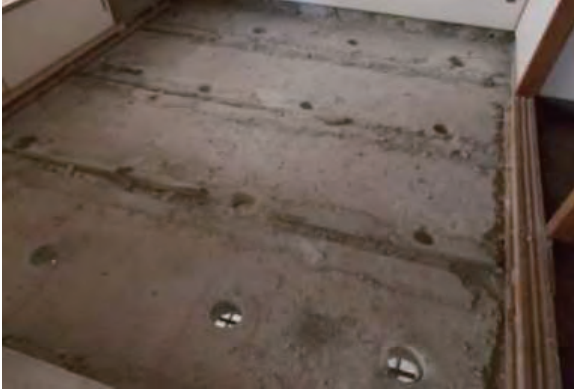
室内床スラブへの流し込みのためのコア削孔状況
