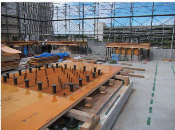
写真-2 在来工法での施工状況
