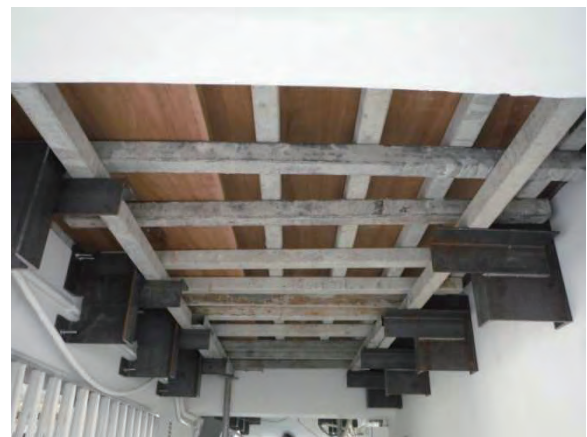
写真-3 共用廊下部の型枠施工状況
