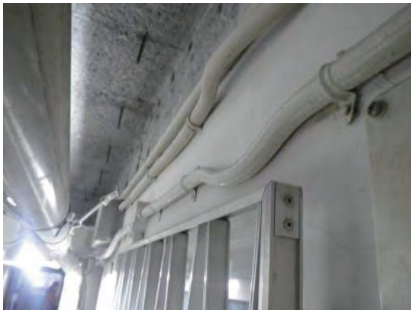
写真-2 共用廊下の壁面の既存配管類
