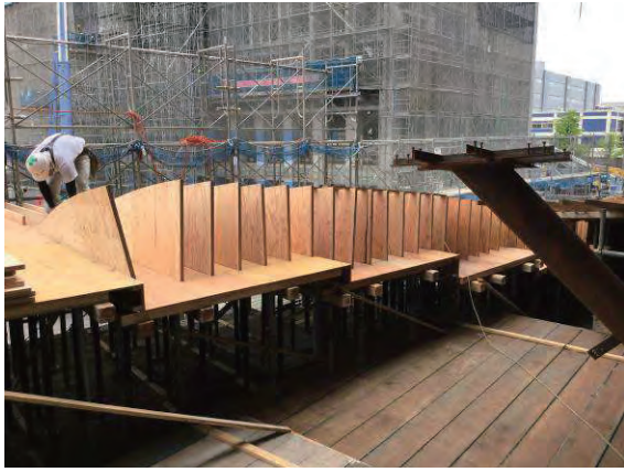
STEP4 くし型施工
