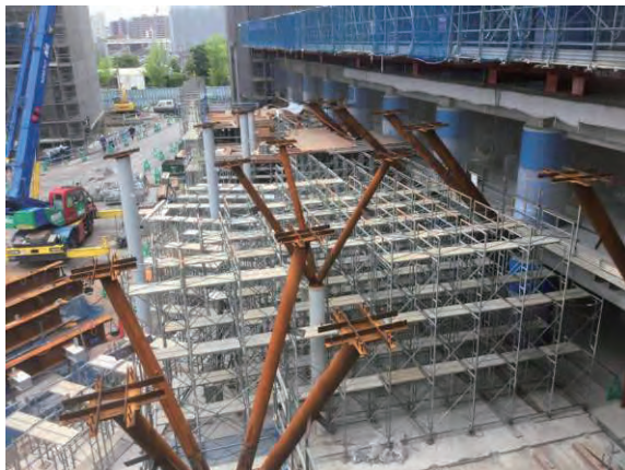
STEP1 階段状枠組支保工設置
