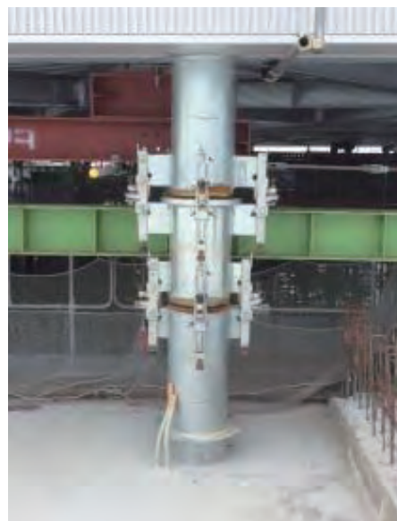
写真 3 間詰材実施状況
