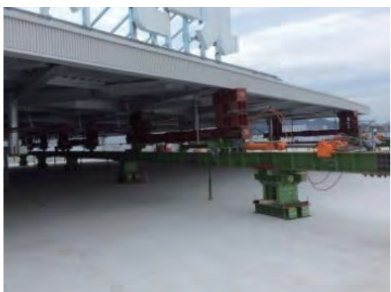
写真 4 大屋根受け鉄骨架台設置状況
