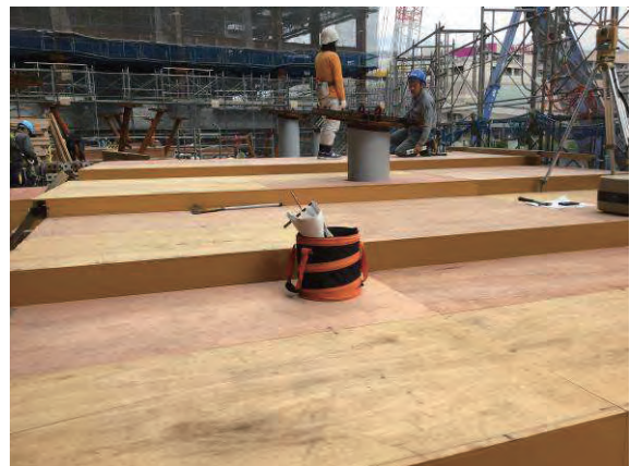
STEP3-2 くし型基準床設置
