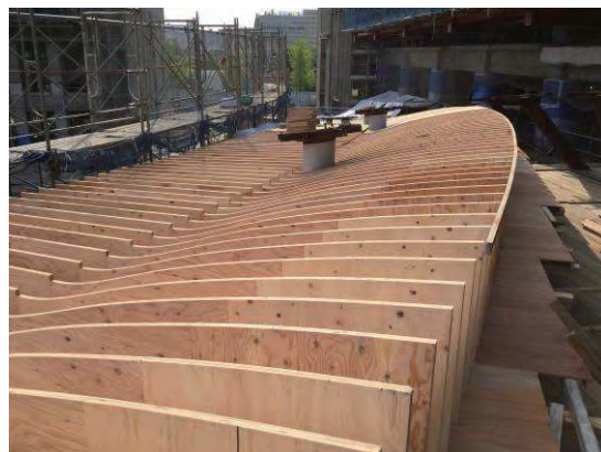
写真－1 くし型曲面型枠施工状況
