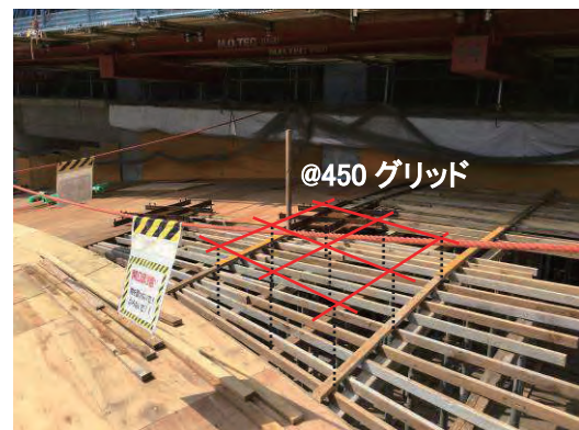
写真-5 在来型枠
