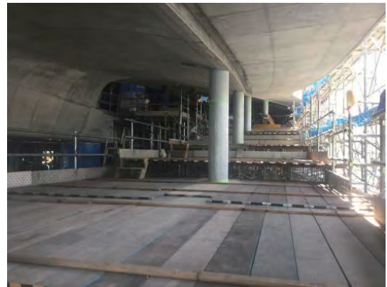
写真-6 躯体出来形
