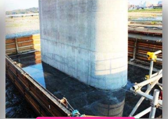
摩耗対策完了
