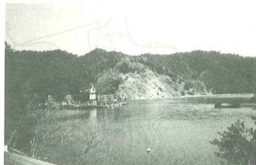
沈埋函曳航状況
