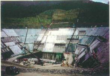
張コンクリート施工状況
