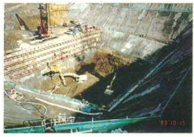
掘削状況 (仮設土留工)
