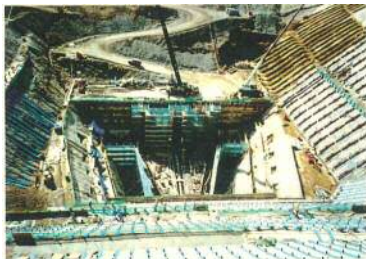
取水口本体施工状況
