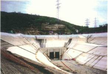
取水口全景 (完成)
