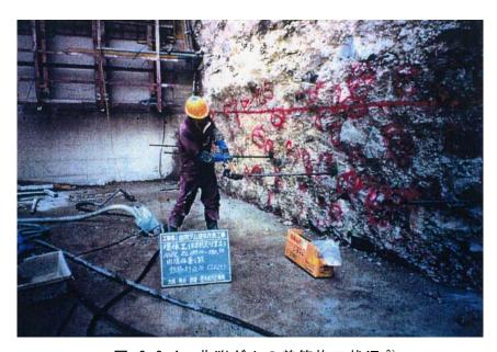
図-2.3.4 曲渕ダムの差筋施工状況 3)
