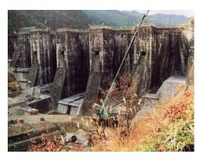
図-2. 2. 14 堤体下流面補修状況 <sup>7)</sup>
