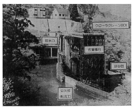
図-2.3.2 飯豊川第一ダムの仮設備全景2)
