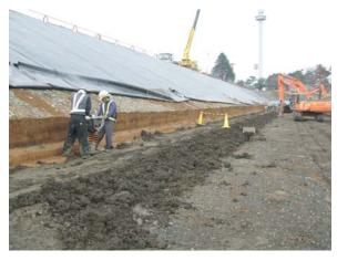
図-2.3.8 村山下貯水池の 接触面小規模盛土<sup>6)</sup>
