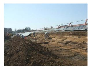
図-2.3.7 村山下貯水池の 接触面仕上げ掘削<sup>6)</sup>
