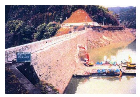
図-2.3.3 曲渕ダムの台船+大型ブレーカによる旧堤体はつり状況 3)
