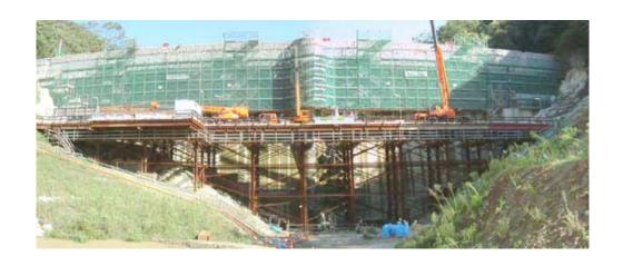
図-2.3.1 布引五本松堰堤の作業用構台 1)
