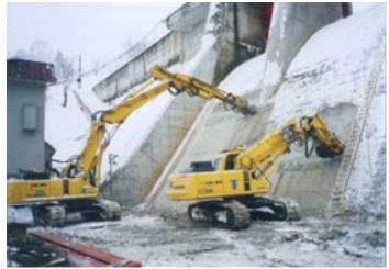
図-2.2.5 コンクリート切削機ラスパール (鷹泊ダムで使用)
