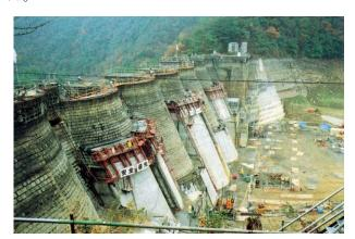
図-2.2.13 堤体上流面補修状況 7)
