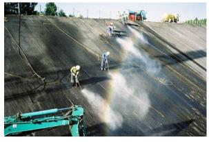
図-2.2.22 切削面洗浄状況 16)
