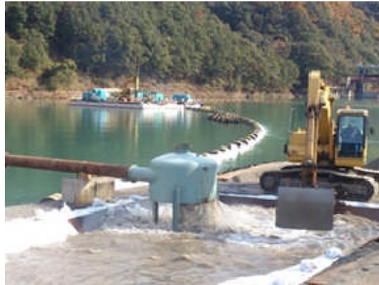
図-1.5.31 浚渫状況（散布側）
