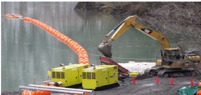
図-1.5.34 エジェクター浚渫工法施工状況
