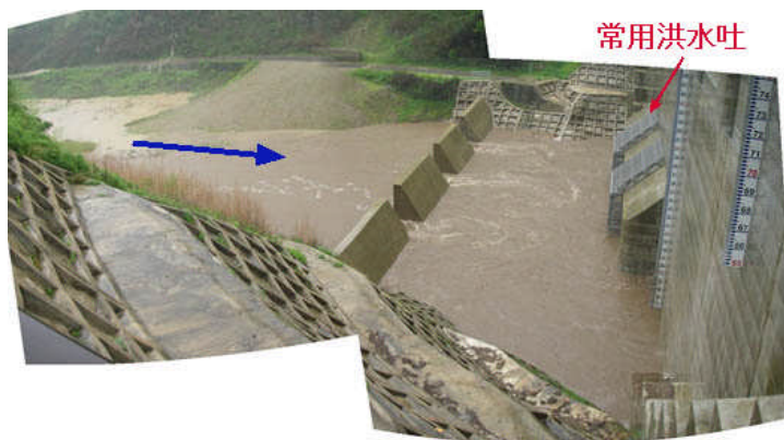
図-1.5.36 ダム上流側 常用洪水吐 24)
