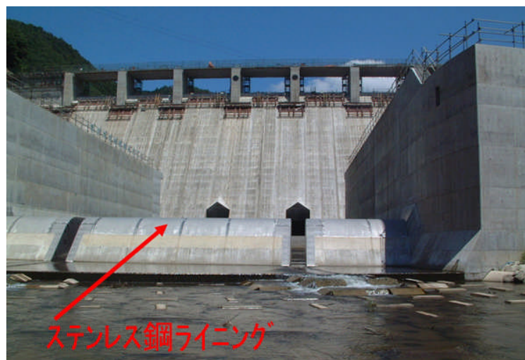
図-1.5.41 副ダム越流部ライニング状況 25)
