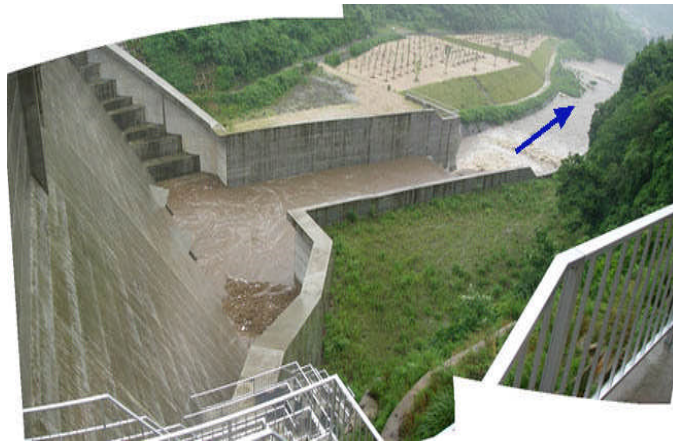
図-1.5.37 ダム下流側 減勢工 24)
