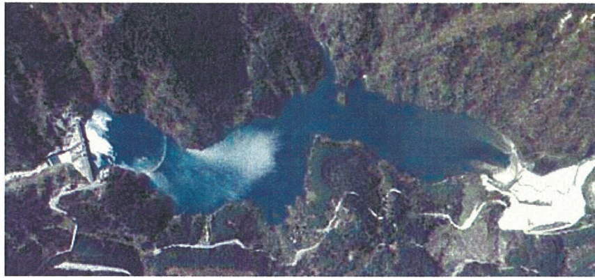
図-1.4.25 堆砂状況(建設後23年経過、平成9年撮影) 16)
