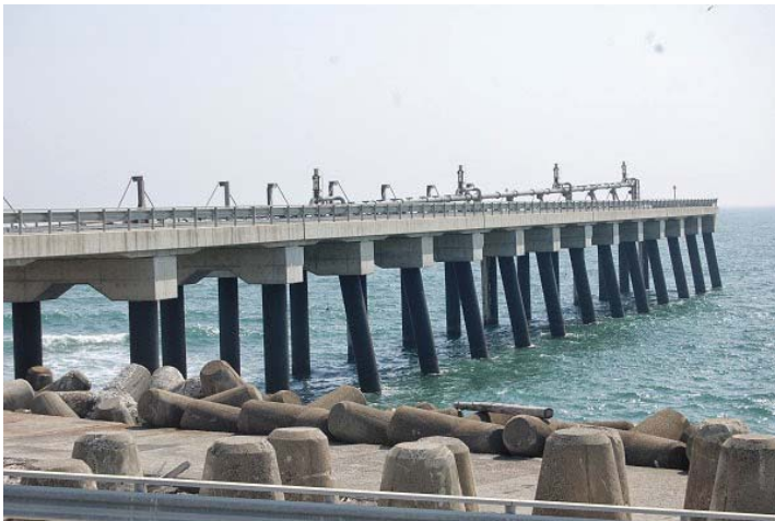
図-1.1.16 ジェットポンプを設置した採砂棧橋 39)
