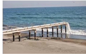
図-1.1.18 2.2キロ離れた海岸に砂を送り出す 39)
