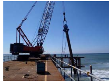
図-1.1.17 架設棧橋から斜杭を打設 39)
