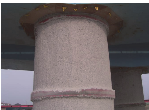
橋脚はつり完了
