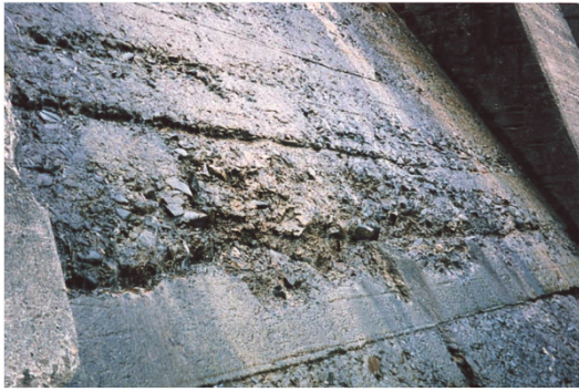
写真2 調査対象のイメージ(構造物表面の凍害)
