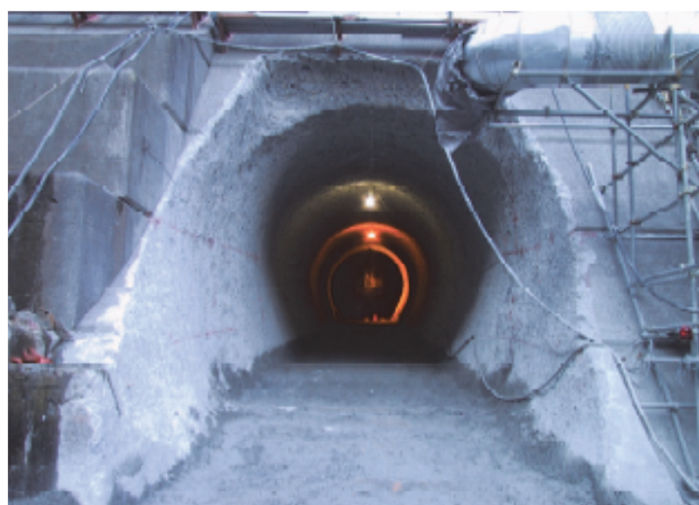
堤体削孔の仕上がり状況
