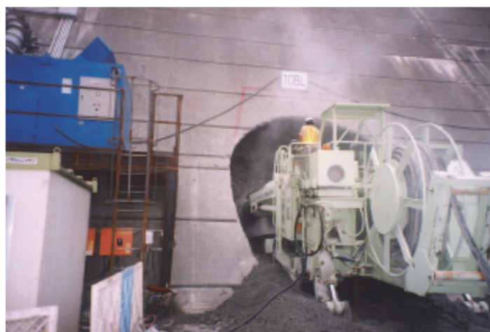
ロードヘッダによる掘削状況
