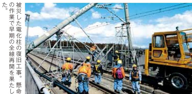
被災した電化柱の復旧工事。懸命の作業で早期の全線再開を果たした。
