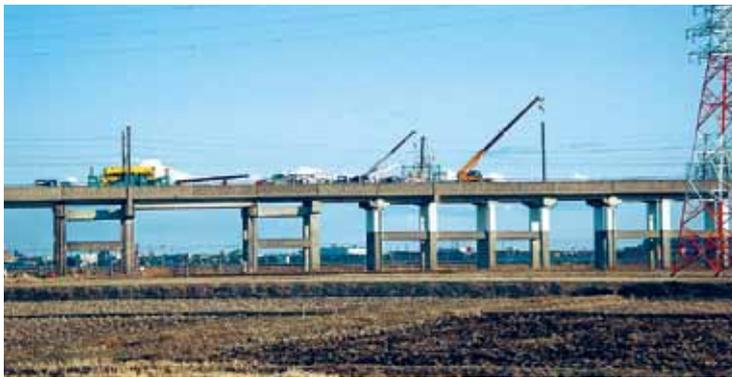
電化柱に被害はあったが、耐震補強により高架橋の被害は少なかった。
