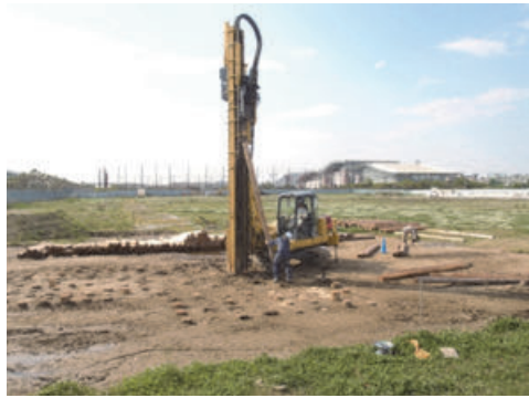
写真-1 施工状況
