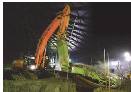
既設構造物直下の施工 (水平トレンチャー方式)
