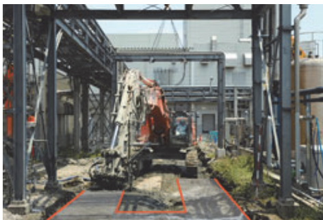
狭隘な現場での施工
