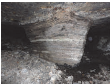
写真-1 亜炭廃坑内部と残柱 (岐阜県御嵩町)
