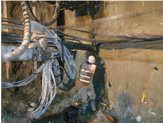
写真7 落石防護ネット
