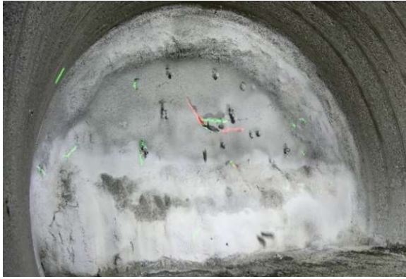
写真5 鏡クラック自動検知システム
