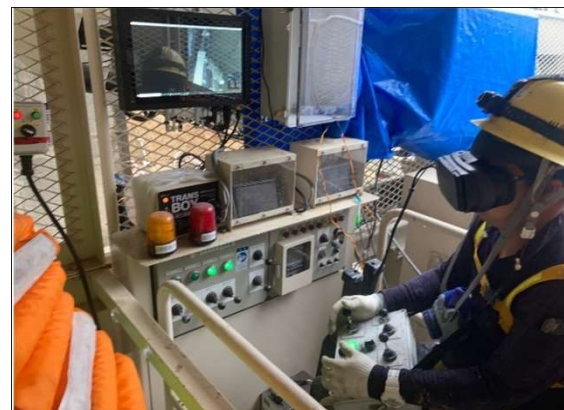
写真9 吹付けロボット遠隔操作状況
