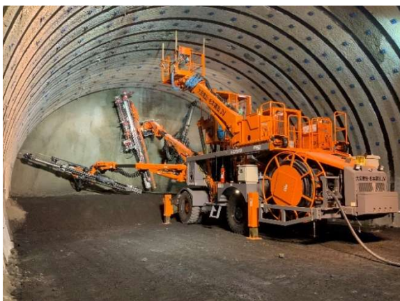
写真 13 ロックボルト打設専用機
