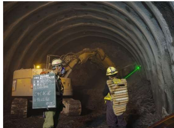
写真8 レーザーポインターによる遠隔での確認
