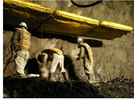
写真6 落石防護マット
