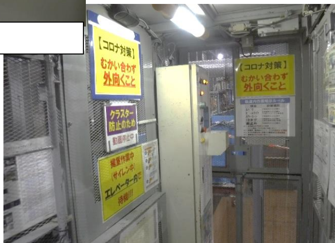
エレベーター内の掲示例
