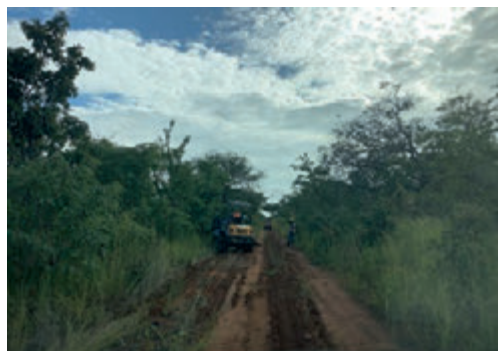
未舗装道路の修繕
