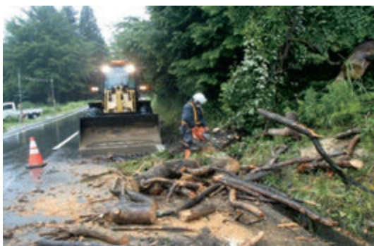
豪雨による倒木の除去作業
