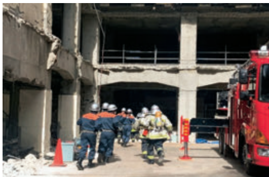
解体現場を消防訓練の場に提供
