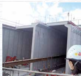
ボックスカルバートの施工の様子
