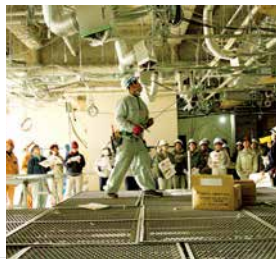
施工状況の説明を受けながら見学
