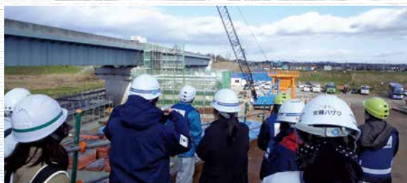
仮設栈橋上から橋梁下部工の現場を見学
