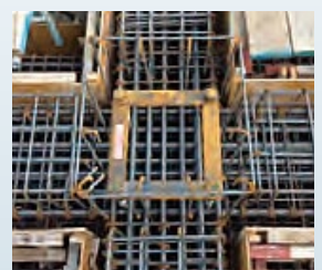
鉄筋施工状況(実施)
