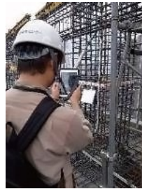
スマートデバイスを活用した配筋検査業務・写真管理の効率化 ※6
