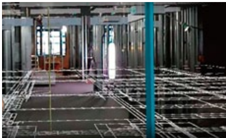
現実空間上に実寸大の図面データを表示 干渉の検討、墨出し・出来形チェック ※7
