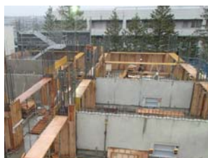
写真-19 後施工状況
