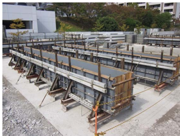
写真-3 小梁PCa製作状況
