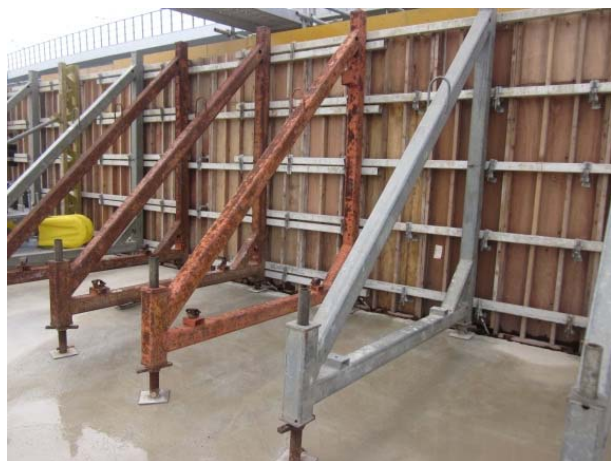
写真-2 ブレースフレーム設置状況
