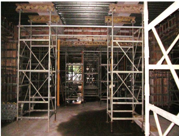
写真-5 ST枠設置状況
