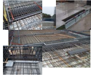
写真-27 段差鋼製型枠
