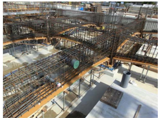
写真-6 大梁鉄筋先組み状況(免震階)
