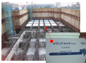
写真-23 型枠検討断熱材
