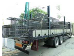
写真-24 大梁筋ユニット搬入
