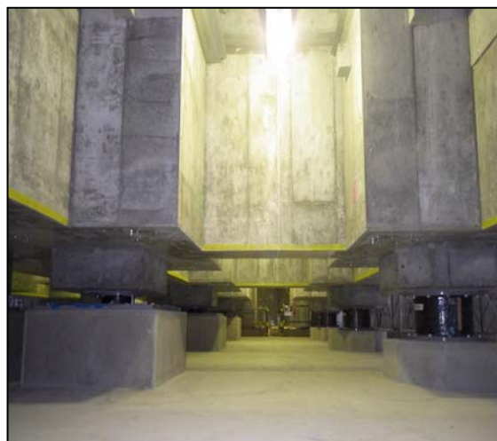
写真-2 免震層全景
