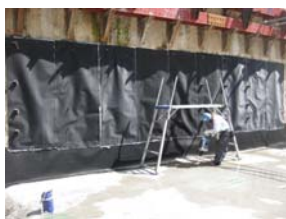
写真-21 山留壁シート防水
