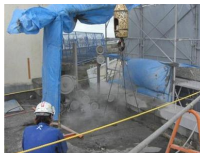
写真-3 ワイヤーソー工法による床解体
