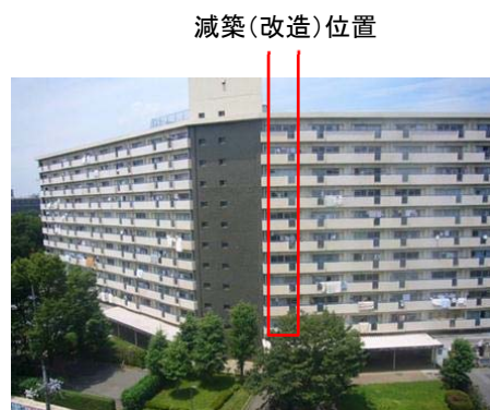
写真-1 住棟分割前建物外観
