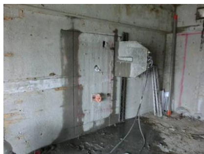
写真-2 ウォールソー工法による壁解体
