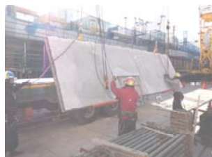
写真-11 建起し状況
