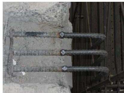
写真-9 主筋アンカー部の溶接継手
