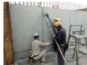
写真-16 建て入れ確認
