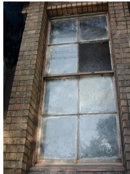
写真-13 既存上げ下げ窓
