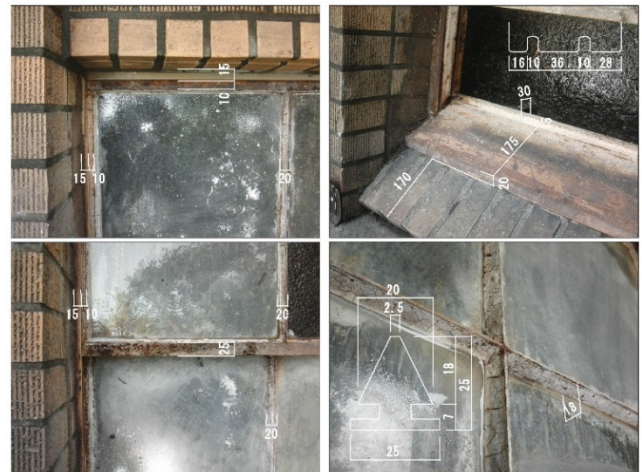
写真-10 既存サッシ実測の部分詳細
