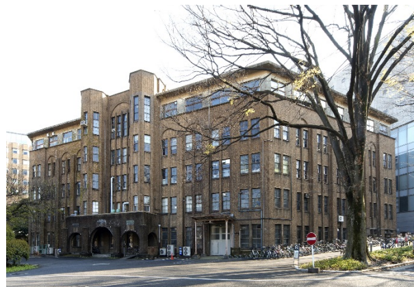
写真-16 既存外観
