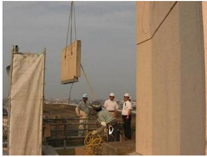
写真-4 小分割による壁コンクリート塊揚重
