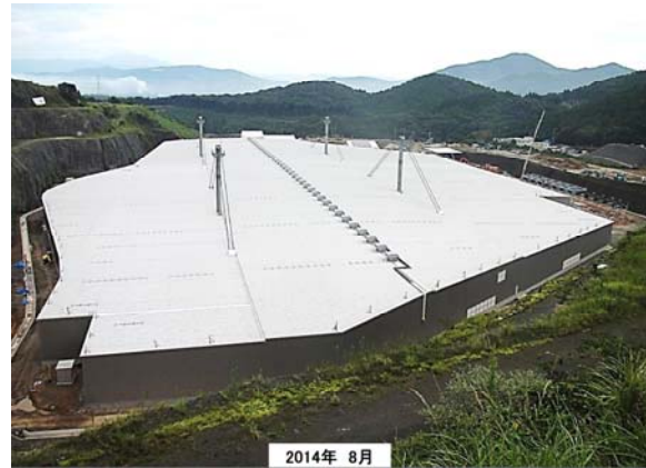
写真-8 屋根の完成
