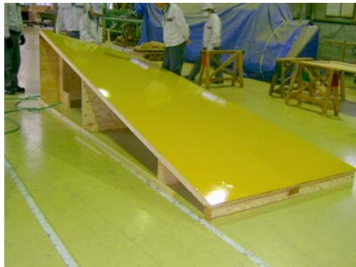
写真-1 型枠振れの確認
