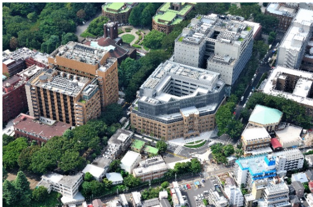
写真-1 完成航空写真
