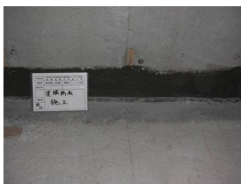
写真-6 戸境壁切付部への仮防水
