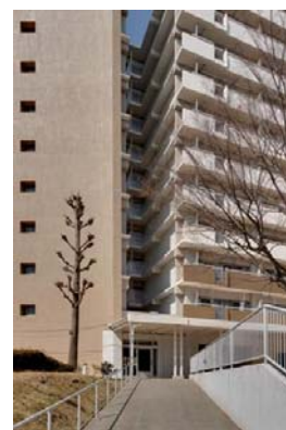
写真-10 減築後の分割部外観
