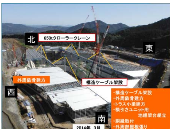
写真-5 外周屋根建方と横引き地組架台設置
