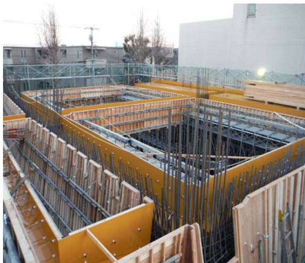
写真-5 HPシェル部 型枠・配筋状況
