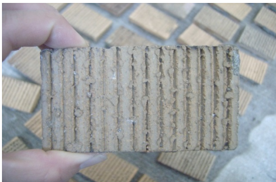
写真-7 既存の面状
