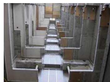
写真-8 屋上への仮設屋根設置 (1階からの見上げ)
