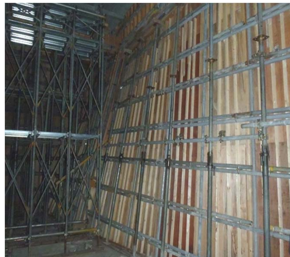
写真-6 型枠建込み状況
