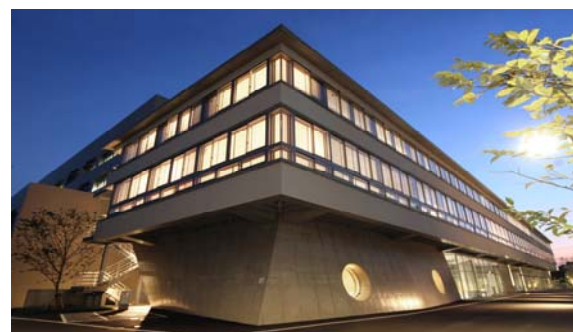
写真-8 外壁仕上げ状況②
