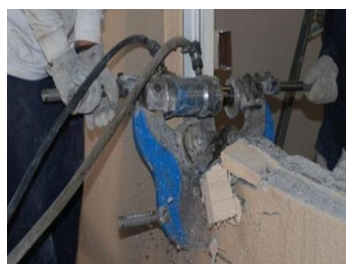
写真-7 ハンドクラッシャー工法 による雑壁解体
