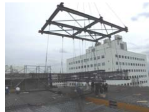
写真-29 梁筋吊治具
