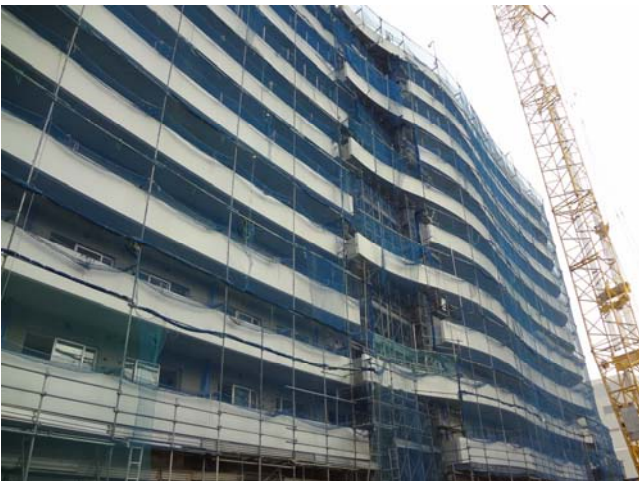
写真-6 曲面バルコニーの垂直養生
