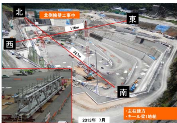
写真-3 北側擁壁工事と南側の屋根工事着手
