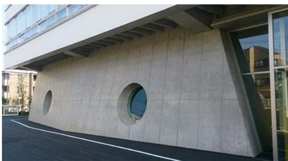
写真-7 外壁仕上げ状況①
