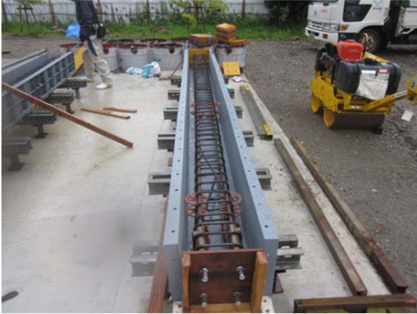
写真-4 マリオンPCa製作状況
