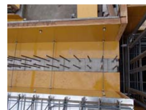
写真-20 梁型枠内定着筋
