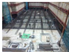
写真-22 地下躯体工事
