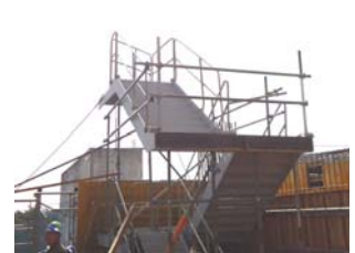
写真-30 鉄骨階段先行建方
