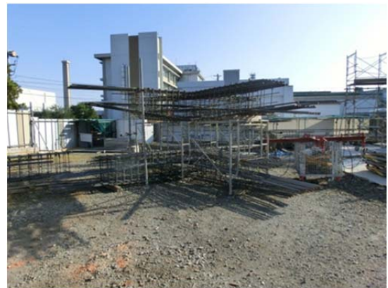
写真-7 大梁鉄筋先組み状況(上部階)
