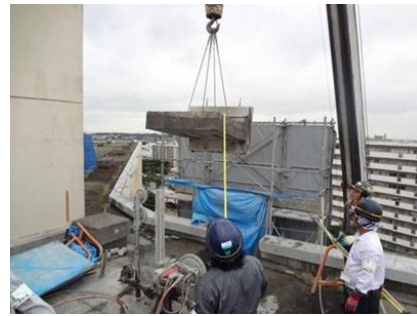
写真-5 小分割による床コンクリート塊揚重
