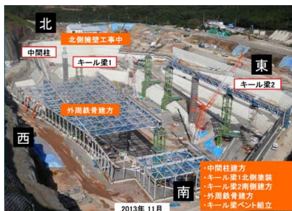
写真-4 南側キール梁建方と北側擁壁工事
