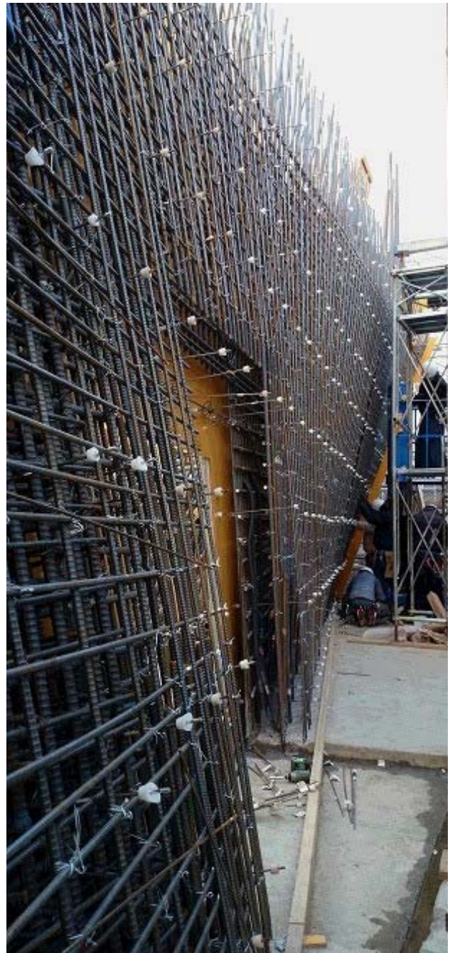
写真-4 壁配筋状況
