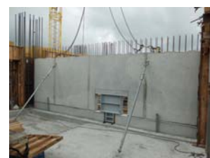
写真-18 取付け完了
