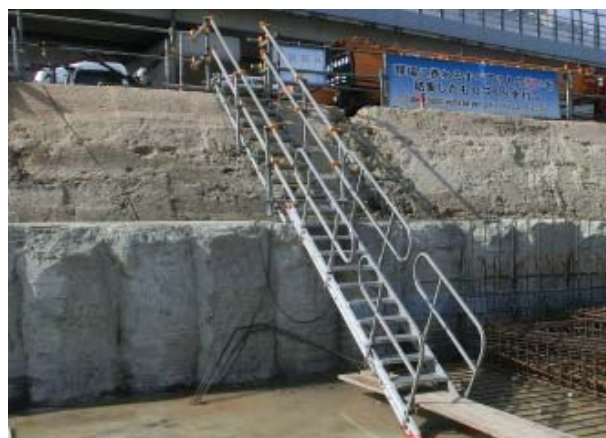
写真－1 地盤改良山留め状況
