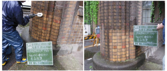
写真-3 既存タイルの洗浄
