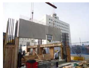
写真-14 セット状況
