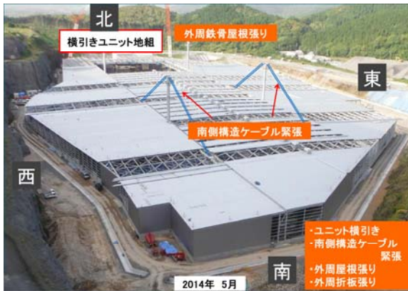
写真-7 南側の構造ケーブルの緊張
