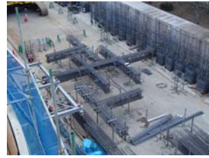
写真-25 柱・梁地組
