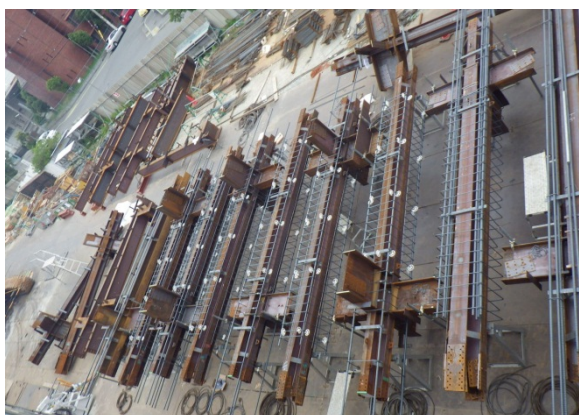
写真-9 地組ヤードでの鉄筋先組状況
