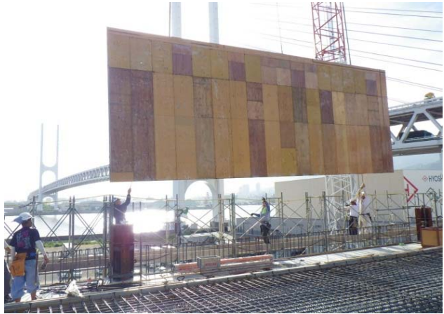
写真-11 大判型枠建て込み状況
