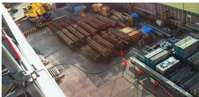
写真-1 柱筋ユニット現場組立状況
