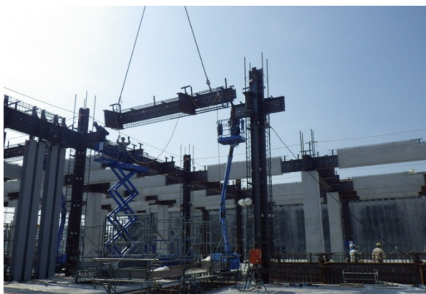
写真-10 現地での据付状況
