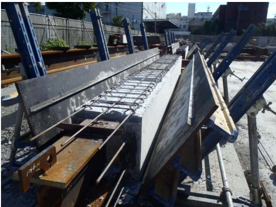
写真-3 サイトPCa 型枠脱型状況
