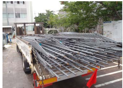
写真-9 梁筋ユニット搬入状況
