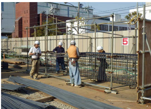
写真-7 地組ヤードでの鉄筋先組状況
