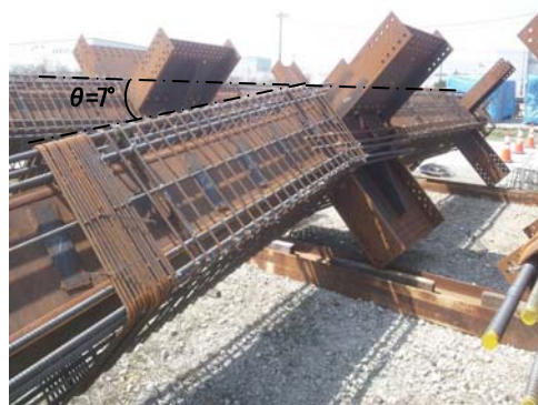
写真1 傾斜柱の鉄筋組状況
