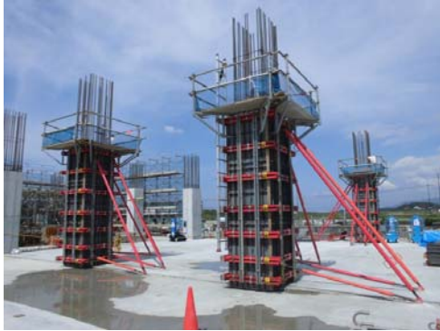
写真-3 柱躯体をシステム型枠にて先行打設
