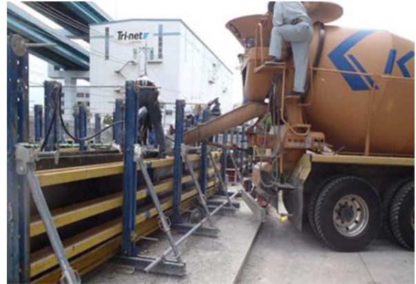
写真-2 サイトPCa コンクリート打設状況
