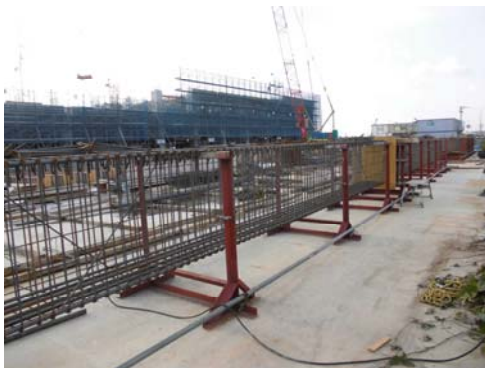
写真-4 鉄筋地組ヤード
