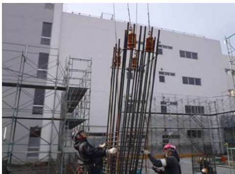
写真-8 柱筋の吊込み状況
