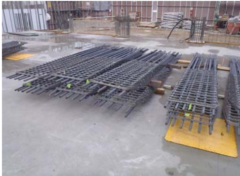
写真-6 柱筋ユニット搬入状況
