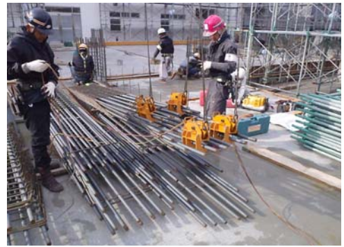
写真-7 柱筋の建起こし状況
