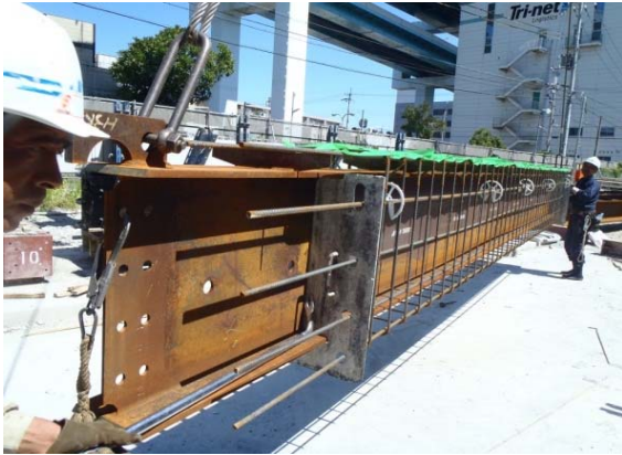
写真-1 サイトPCa 配筋状況
