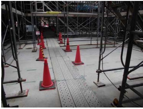
写真-15 雨でも靴が濡れない作業通路
