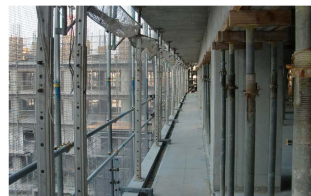
写真-5 外部の垂直養生
