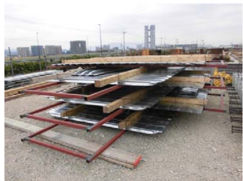
写真-8 フラットデッキの地組
