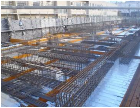
写真-5 梁筋ユニット仮置き状況
