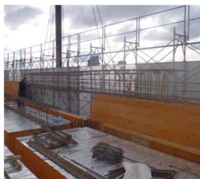
写真-4 梁筋ユニット吊り込み状況
