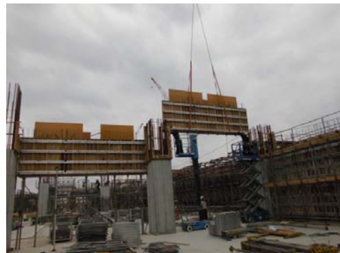
写真-7 下り壁の吊り込み
