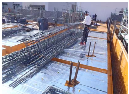
写真-11 梁筋の復元状況
