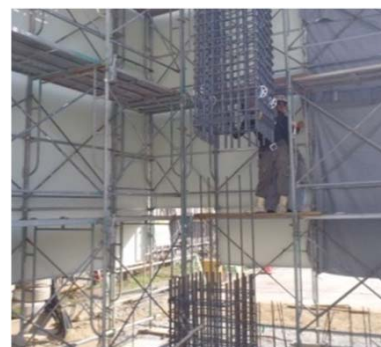
写真-2 柱筋ユニット取付状況
