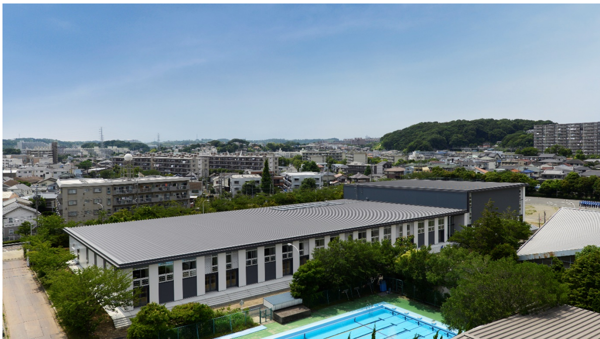
写真－1 竣工後全景
