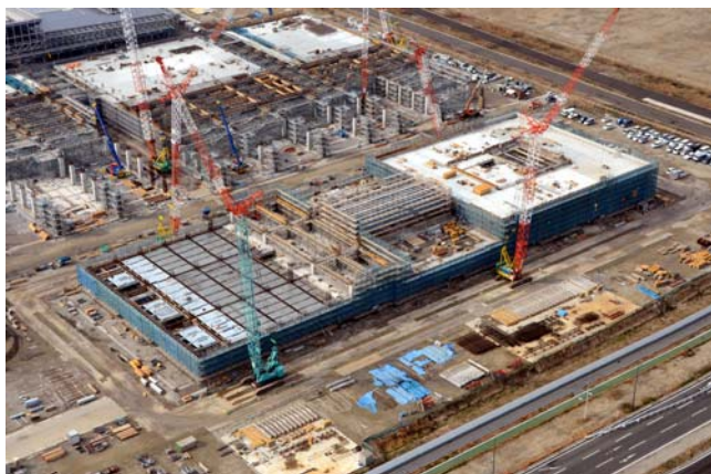
写真-1 現場全景
