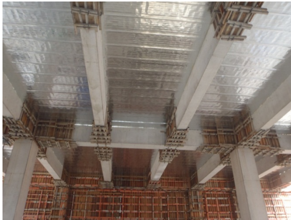
写真－５ 吊金物使用状況
