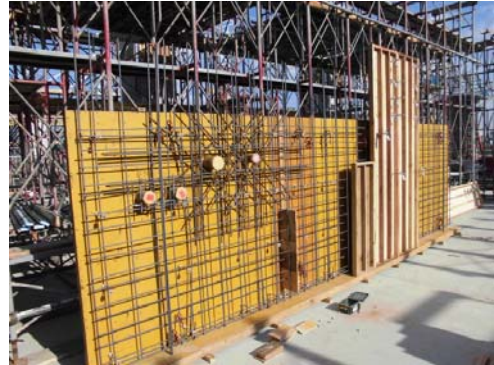
写真-6 下り壁の地組
