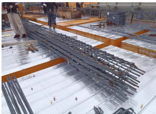
写真-10 荷揚げ状況(仮置き)
