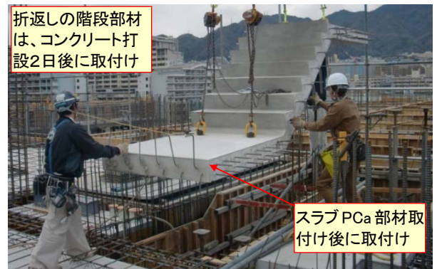
写真-4 階段フルPCa部材取付け状況
