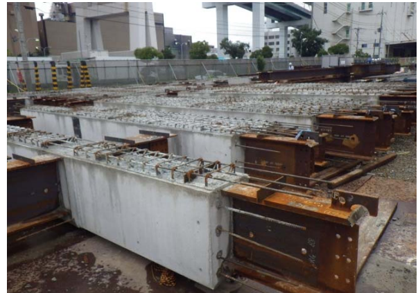
写真-4 PCa 製品保管状況
