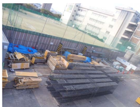
写真-3 梁筋ユニット現場組立状況
