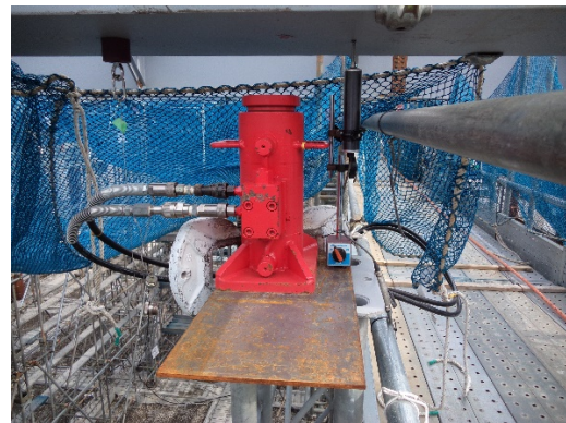
写真-3 ジャッキ据付状況
