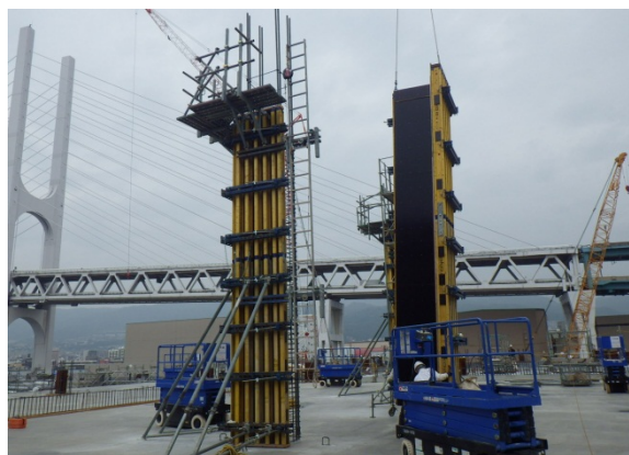
写真-8 システム型枠設置状況
