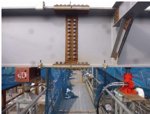
写真-2 ジャッキ据付位置
