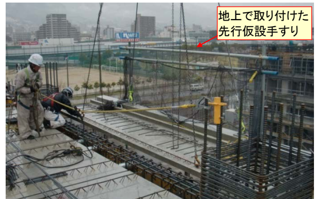
写真-3 バルコニーハーフPCa部材取付け状況
