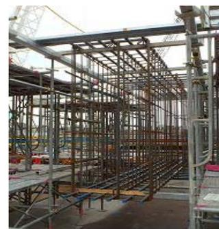
図 1 2 基礎梁先組み
