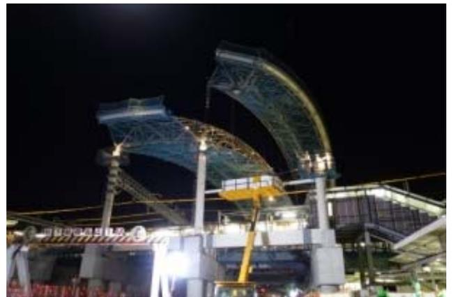
写真8 トラスブロックの架設状況
