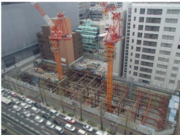
写真－3 3月1F先行床、地下躯体施工状況
