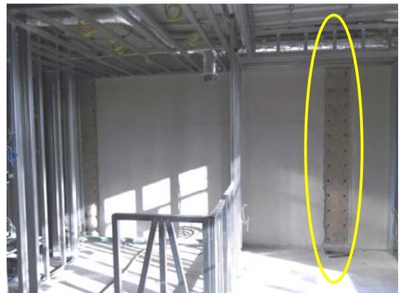
写真-12 支持架台柱部 12mm欠き込み状況
