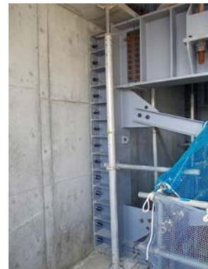
写真-7 支持架台固定状況
