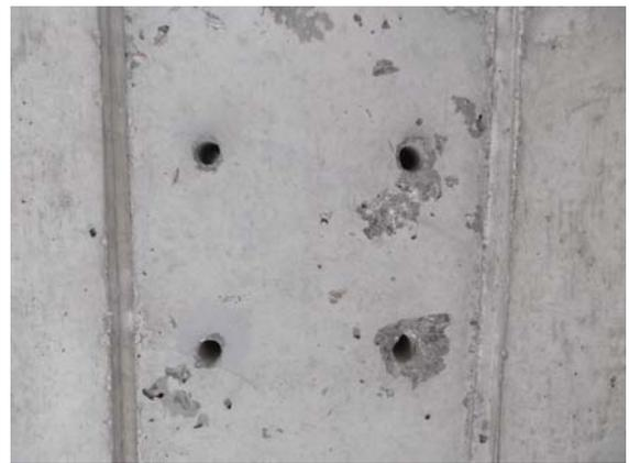
写真-11 支持架台柱部固定用ボルト撤去状況
