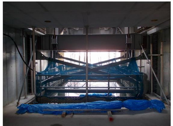
写真-6 耐震壁打設後の支持架台設置状況
