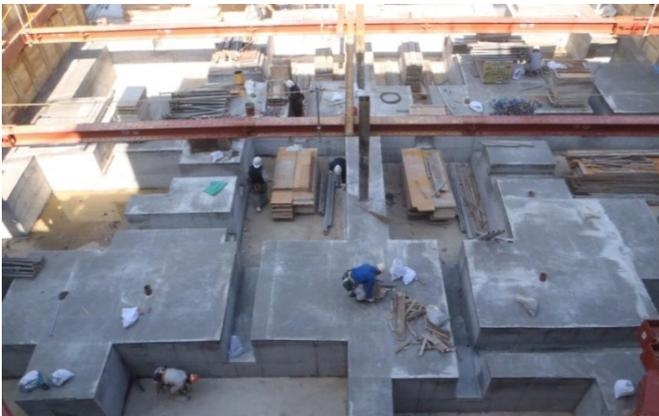
写真-3 捨てコンクリート型枠出来型(近影)
