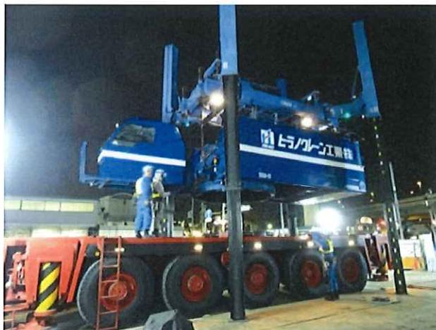
写真5 リフターを用いたクレーン組立状況
