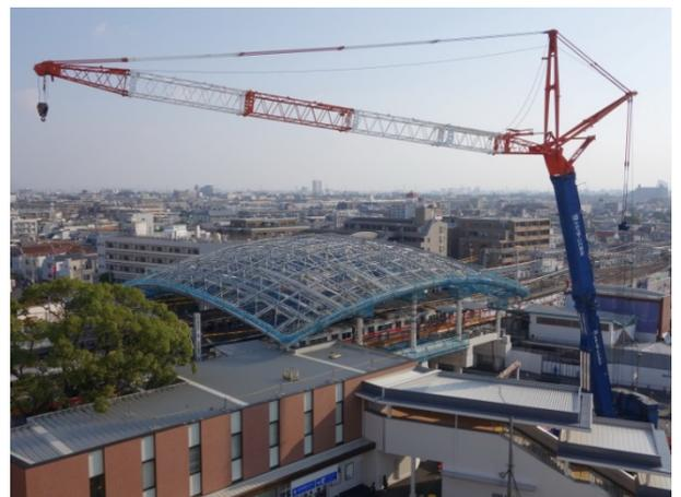
写真 13 鉄骨トラス完了時全景
