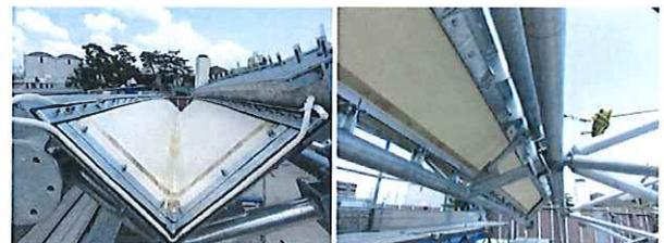
写真 10 軒樋の施工状況
