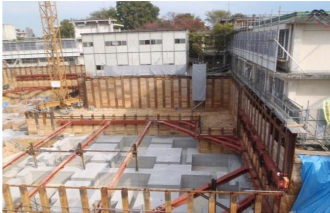
写真-2 捨てコンクリート型枠出来型
