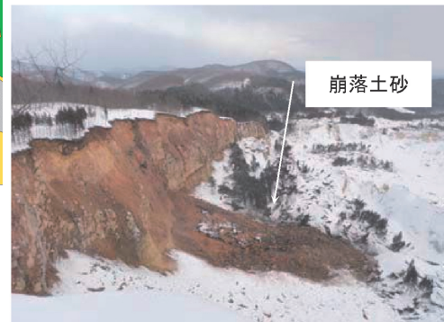
写真-2 東側斜面の崩落
