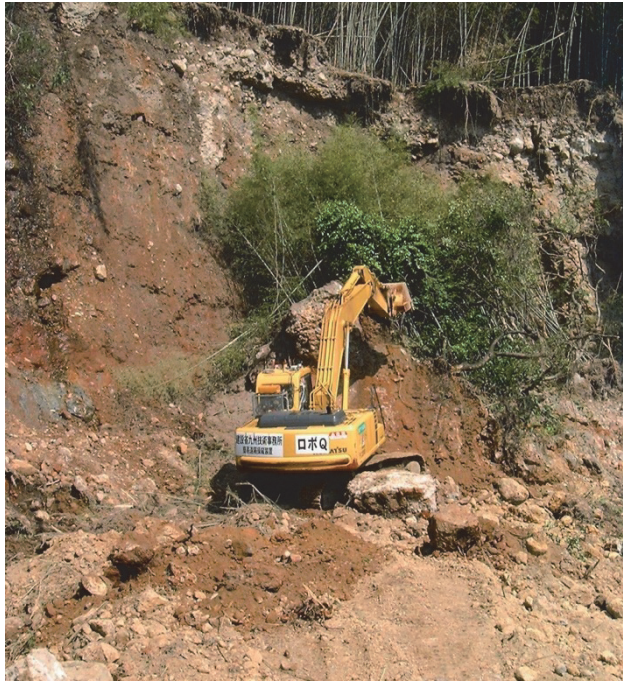
写真-4 遠隔操作ロボットを装着したバックホウ
