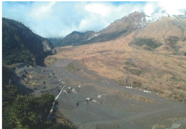
写真-3 現場全景
