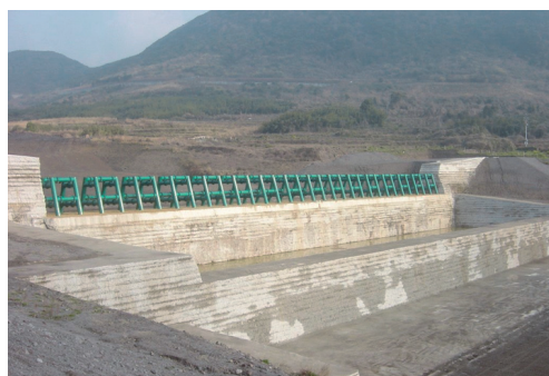
写真-8 竣工状況
