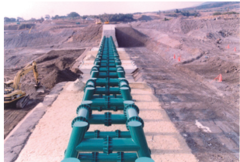
写真-7 鋼製スリット配置完了状況
