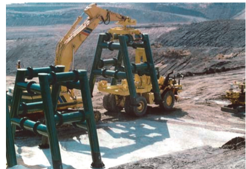
写真-3 鋼製スリット据付け状況
