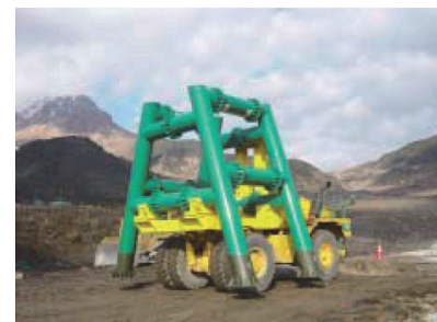
写真-1 スリット運搬状況
