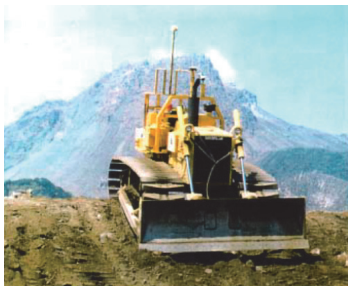
図-9 法面掘削状況
