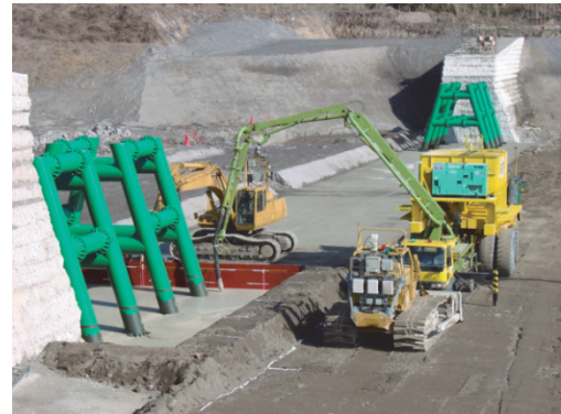
写真-5 無人ポンプ車による打設状況
