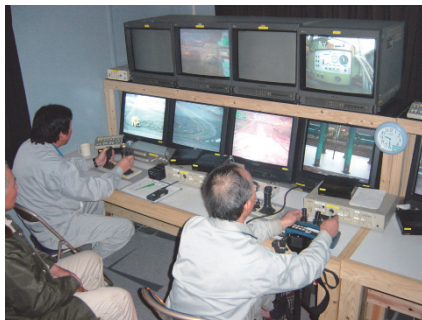
写真-6 高流動コンクリート打設遠隔操作状況
