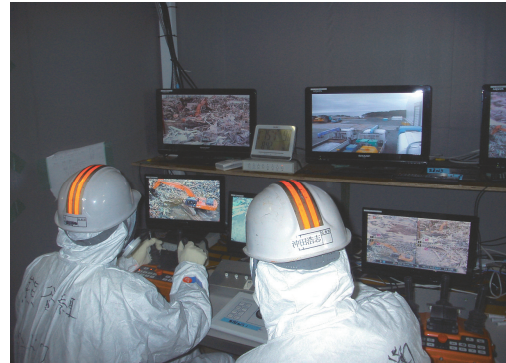
写真-2 無人化施工機械の操作状況
