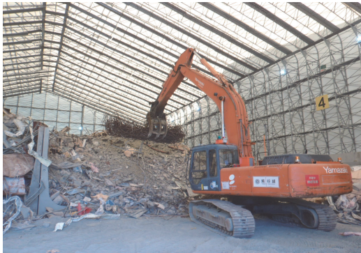
写真-1 無人化施工機械による減容化作業
