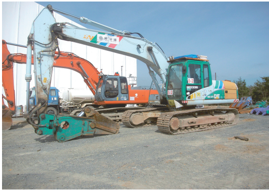
写真-5 無人化施工機械
