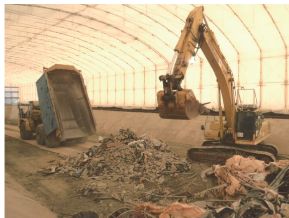
写真-4 高線量ガレキ収容状況
