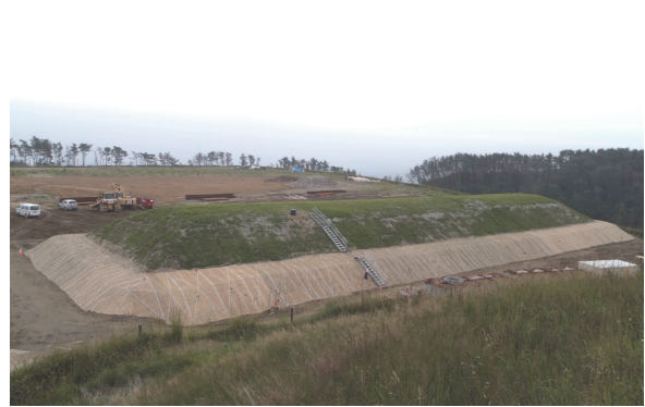
写真-6 覆土式一時保管施設 (完了)
