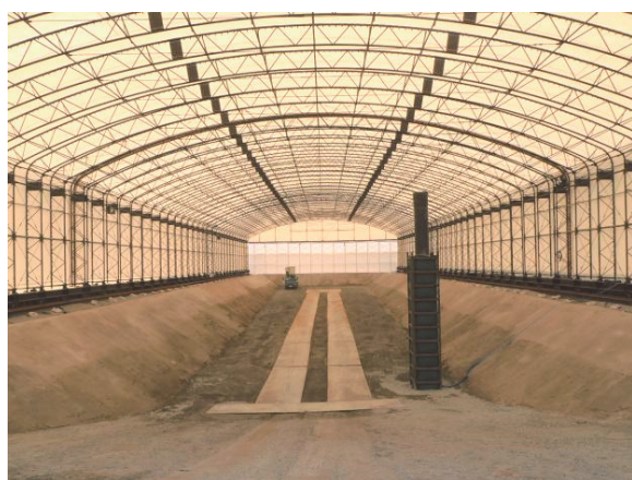
写真-3 覆土式一時保管施設
