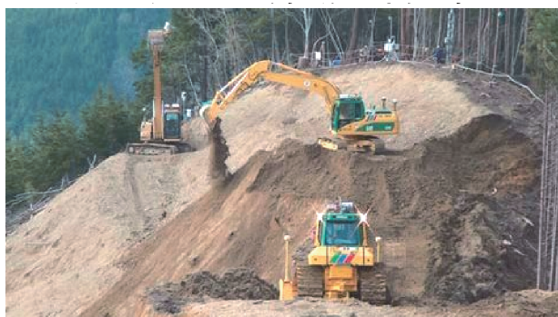
写真-1 北股地区河道閉塞緊急対策工事施工状況
