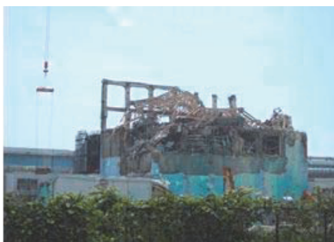
図-1 原子炉建屋解体状況(東京電力 HP より)
