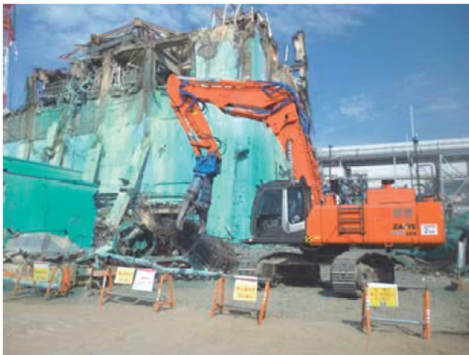
図-2 遠隔操作解体用油圧ショベル
