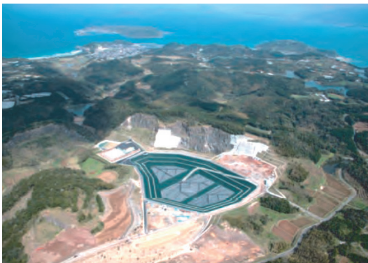
写真-1 造成工事竣工時の鎮西最終処分場
