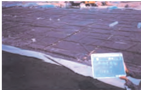
写真-2 電極敷設状況
