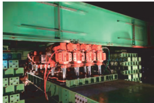
写真-3 駆動シンクロジャッキ
