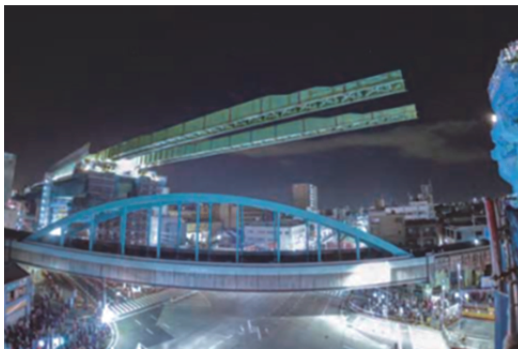
写真-2 第1回桁送出し全景
