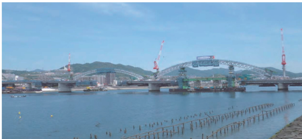
写真-1 アーチ主構の台船一括架設図
